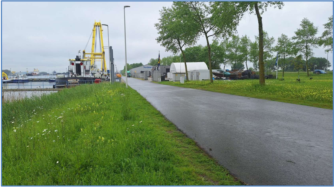
Toegangsweg naar het Bedrijventerrein Goessekade vanaf het sluiscomplex. De ecologisch waardevolle graslandjes en oeverzone blijven in stand.
