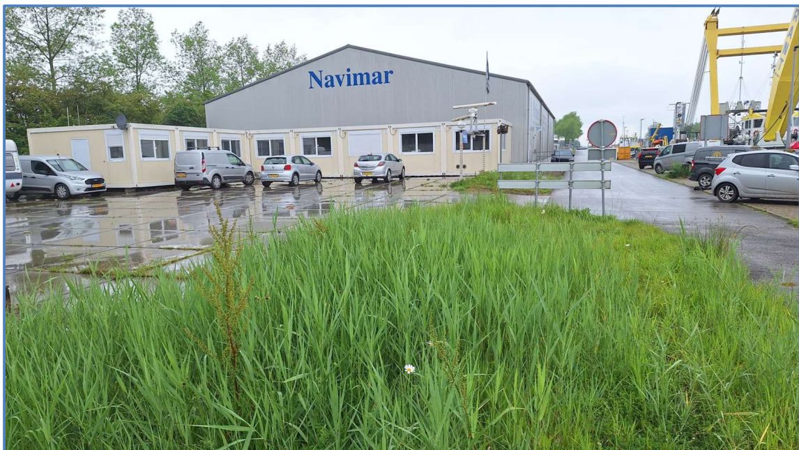
De huidige loods van het bedrijf 'Navimar' op Bedrijventerrein Goessekade.
