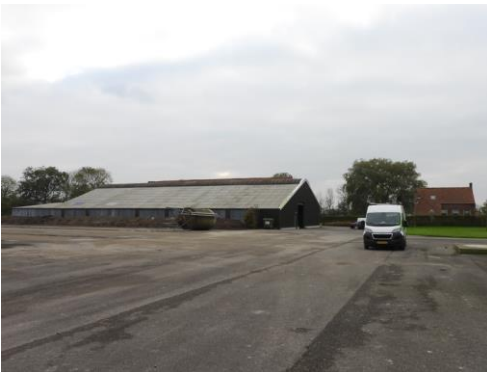
Foto 5: te slopen schuur (links)
