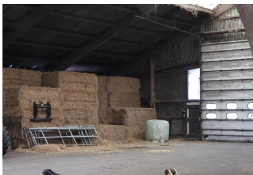
Foto 10: te slopen schuur, rechts de buitenmuur van de oude schuur die blijft staan
