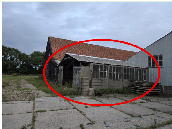
Foto 2.5: te slopen schuur t.b.v. van opslag van machine en materialen, betreft aanbouw van de grotere te slopen schuur
