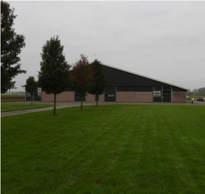
Foto 1: te slopen veeschuur
