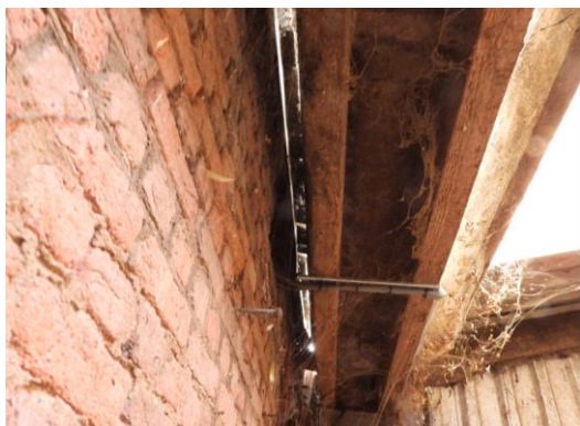
Foto 13: overgang oude schuur (muur links) met jongere te slopen schuur (rechts)
