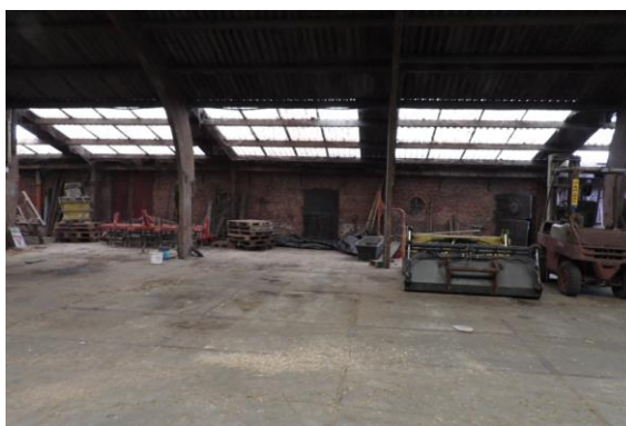
Foto 12: te slopen schuur, met op achtergrond de buitenmuur van de oude schuur die blijft staan
