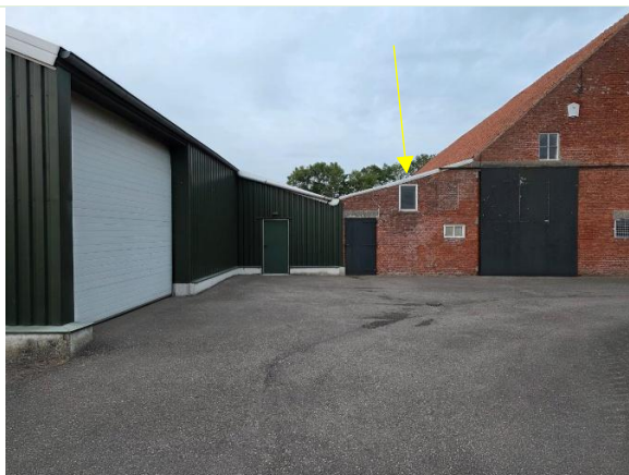
Foto 2.8: gele markering geeft locatie van een zomerverblijf van de Gewone dwergvleermuis aan. Hier zijn 4 gewone dwergvleermuizen achter de daktrim aangetroffen. Links de (groene) schuur voor machine en materialen opslag (sloop)
