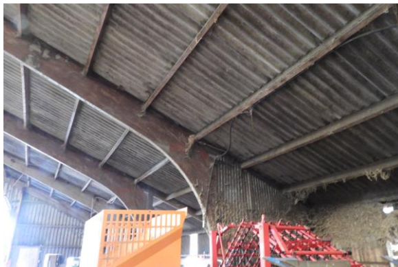
Foto 8: te slopen schuur, houten spanten, asbesthoudend dak met boerenwaluwnest
