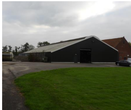
Foto 6: te slopen schuur (links)
