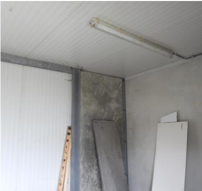
Foto 3: te slopen veeschuur
