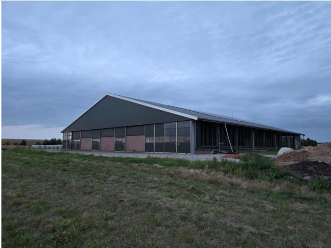
Foto 2.1: te slopen melkveestal
