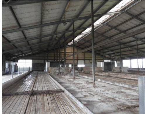
Foto 2: te slopen veeschuur
