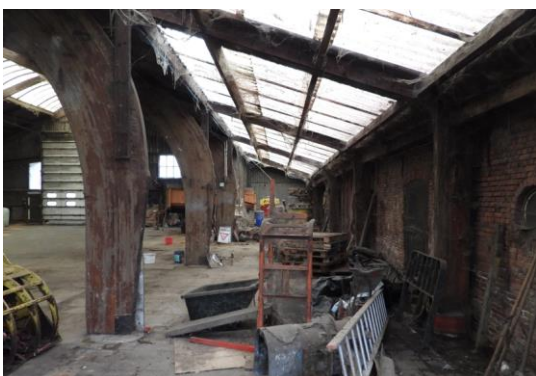
Foto 11: te slopen schuur, rechts de buitenmuur van de oude schuur die blijft staan
