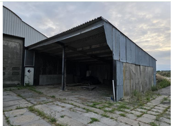
Foto 2.6: te slopen schuur (wagenhuis) t.b.v. van opslag van machine en materialen, betreft aanbouw van de grotere te slopen schuur
