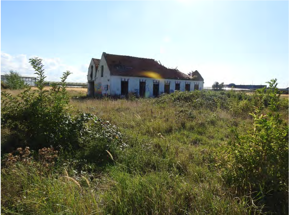
Foto 1. Te slopen bebouwing.
