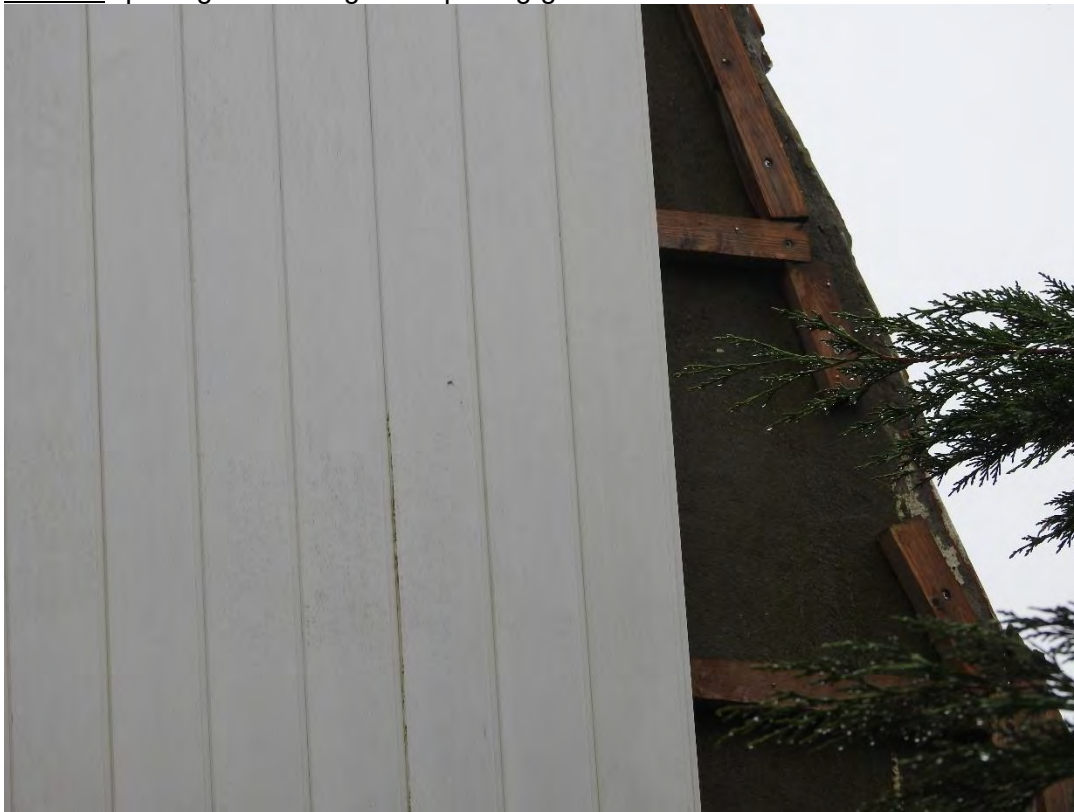
Foto 5. Openingen achter gevelbeplating geschikt voor vleermuizen.
