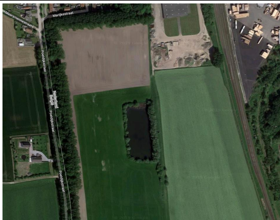
Bovenaanzicht noordzijde locatie
