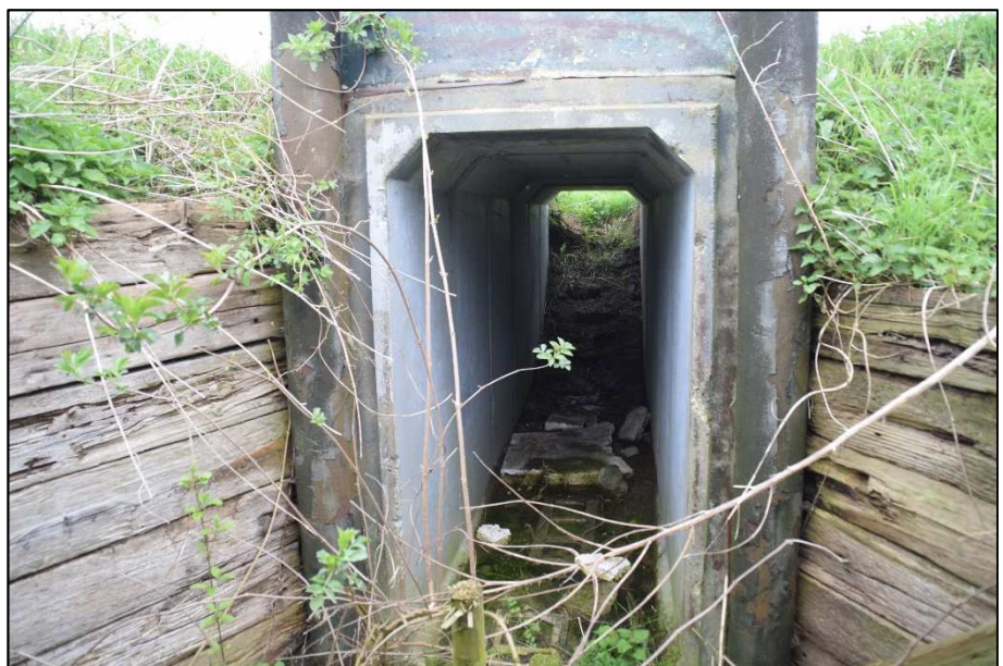
Korte betonnen toegangstunnel naar hut.
