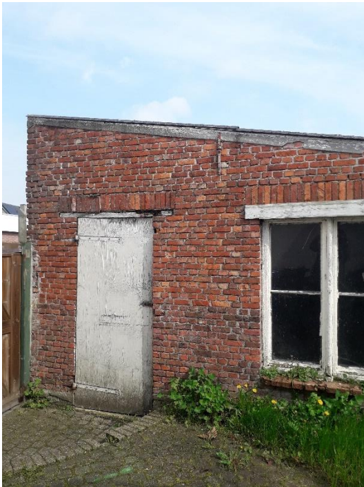
Foto 2: Schuurtje aan achterzijde woning Philipsplein 2
