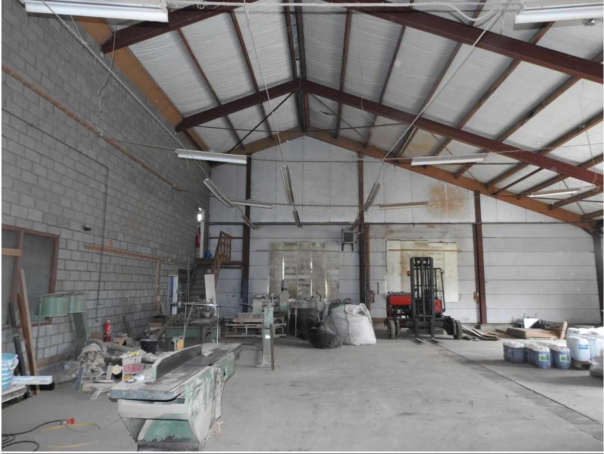
Foto 2. Te slopen bebouwing.
