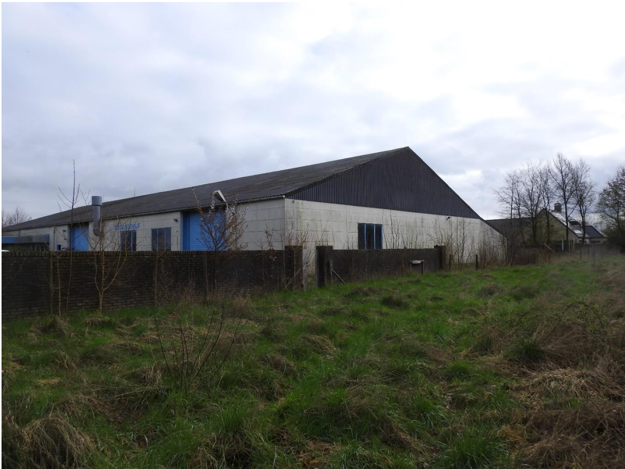
Foto 1. Te slopen bebouwing.
