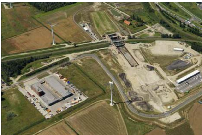
Detailopname van de ligging van het gebouw van de hulpdiensten ten opzichte van de Sluistunnel (in aanbouw). De slingerende weg op de voorgrond is de Koegorsstraat. Ten behoeve van de aanleg van de N62 zal de Koegorsstraat ter plaatse worden afgesloten. In de omgeving van het hulpdienstengebouw zijn windmolens geplaatst. Ten oosten van de kazerne, ten zuiden van de te realiseren ontsluitingsweg, is een werkweg gelegen voor onderhoud van de windmolens.
