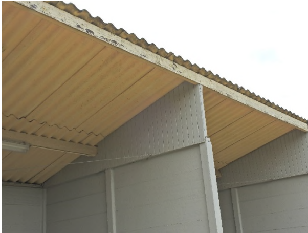
Afbeelding 4.13 deellocatie 5, te slopen afslaggebouw
