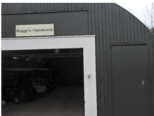
Afbeelding 4.5 deellocatie 3, te slopen romneyloods
