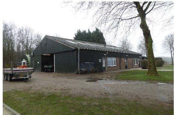
Loods t.b.v. opslag en onderhoud
