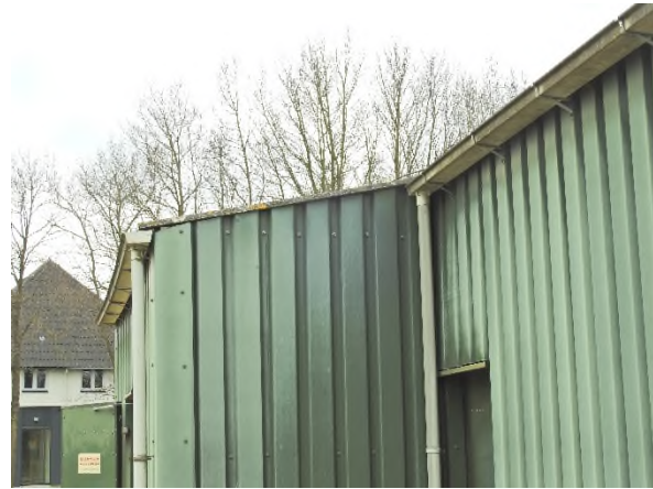
Afbeelding 4.14 deellocatie 5, te slopen afslaggebouw
