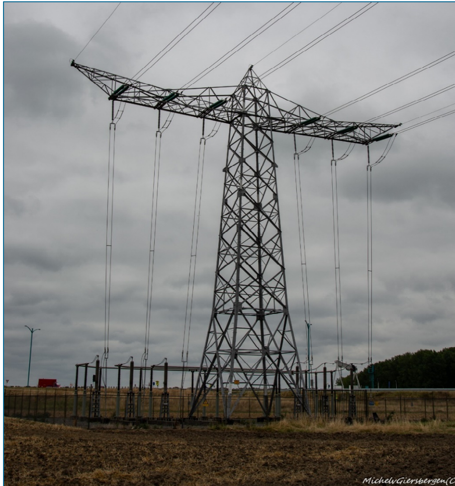
Figuur 3.2: Foto van de hoogspanningsmast. Het betreft een eind-mast: de leidingen gaan hier de grond in. De mast heeft een geringe hoogte (minder dan 50 m).
