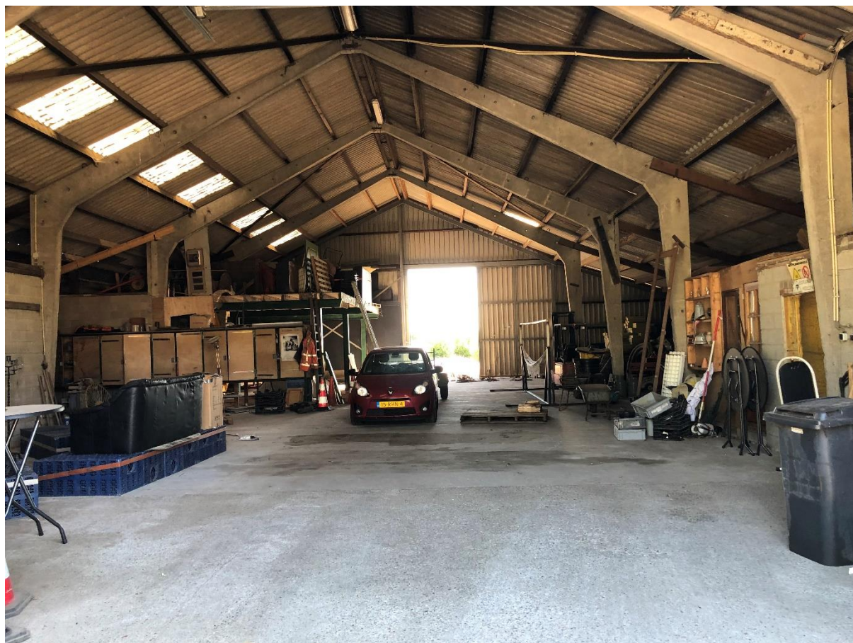
Afbeelding 4.1. Impressie binnenzijde te slopen loods. Aan beide zijden zijn de betonblokken opbouwen te zien. Aan de achterzijde de stalen stellage met daarboven opslag.
