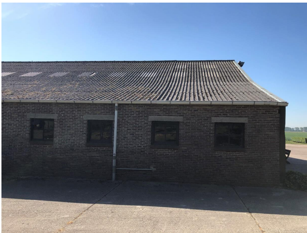
Afbeelding 4.2. Enkelsteense gevel met hierin de houten kozijnen.
