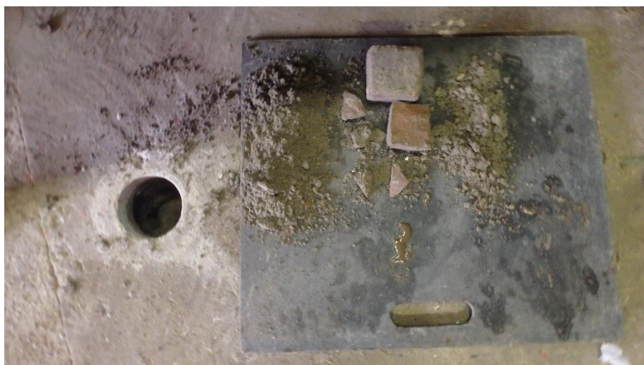
foto 6: werkplaats boring 202 (- richting)
