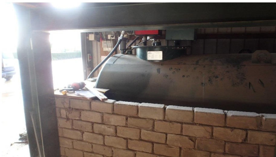
foto 11: ligging tank (zuidwestelijke richting)
