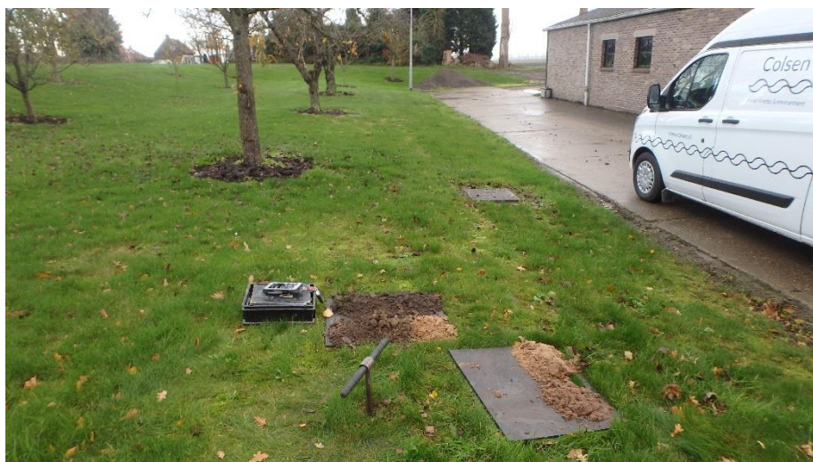
foto 3: boring 112, bodemopbouw tot 300cm-mv (- richting)
