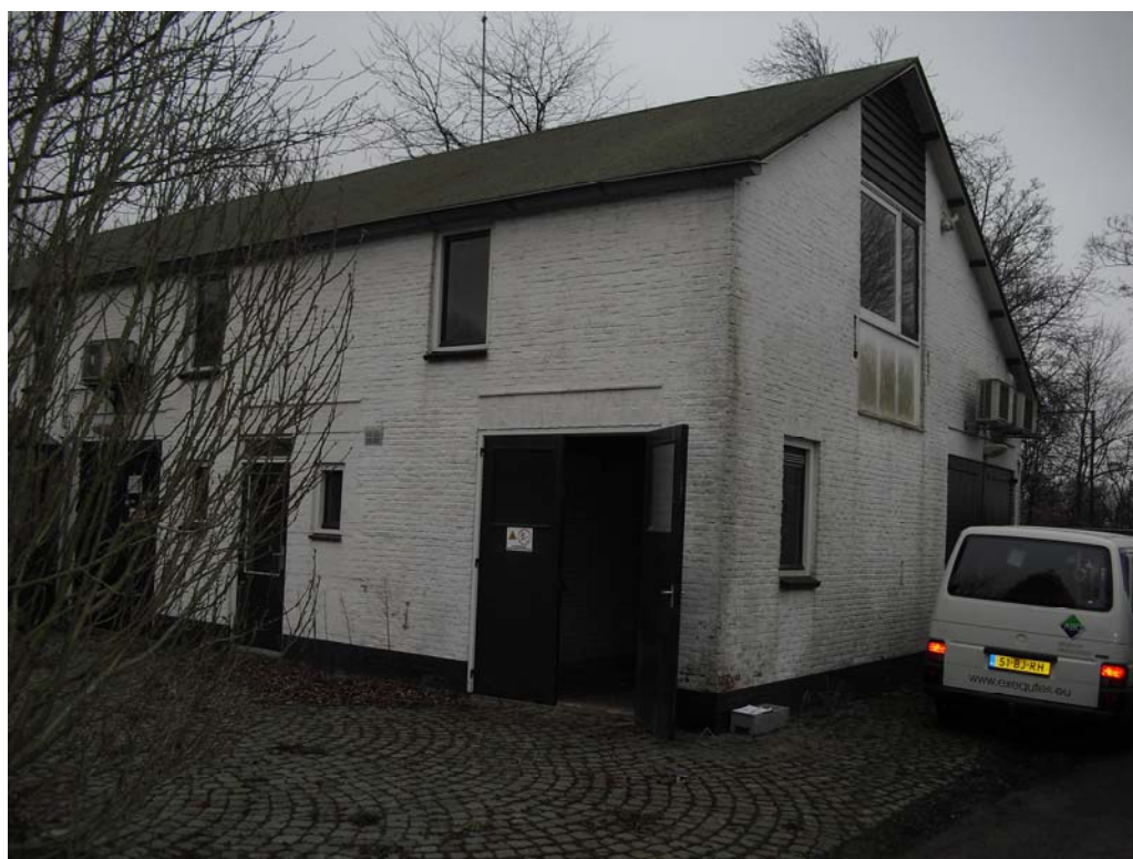
Foto 5: foto risicolocatie 1, bestrijdingsmiddelenopslag
