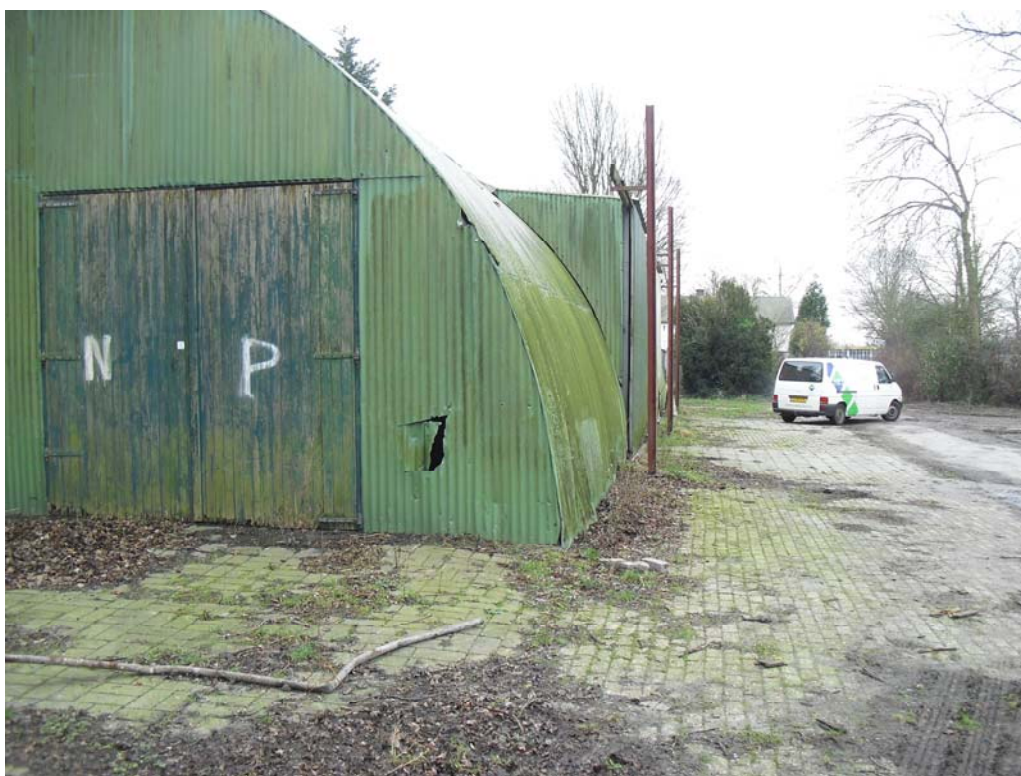
Foto 4: foto van risicolocatie 3 en buitenzijde risicolocatie 2a+2b
