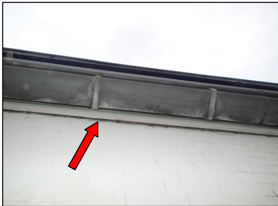
Foto 7: Geschikte ruimte achter betimmering voor vleermuizen
