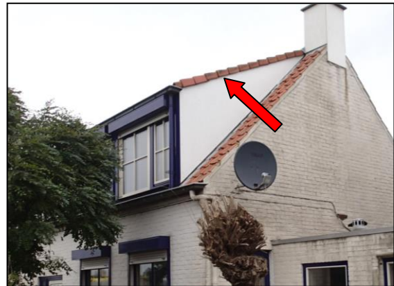
Foto 8: Geschikte ruimtes achter dakpannen voor vleermuizen
