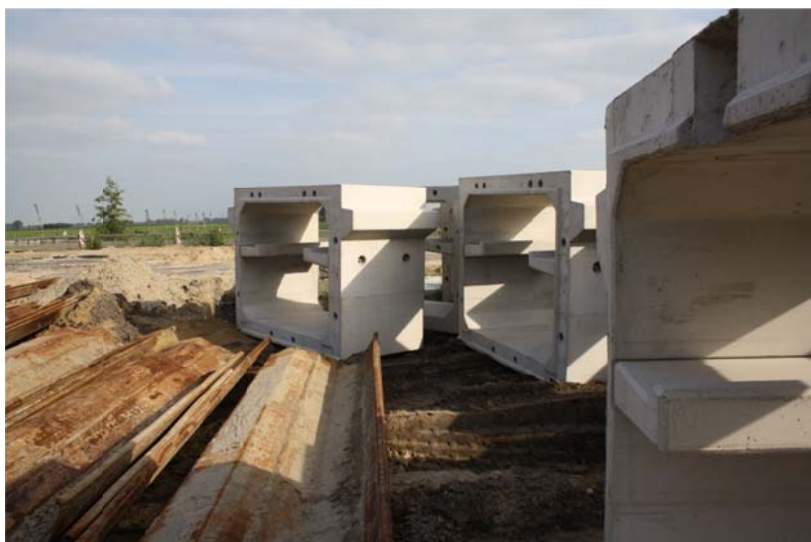
Voorbeeld materiaal ecoduiker met aan weerszijden loopstroken.
