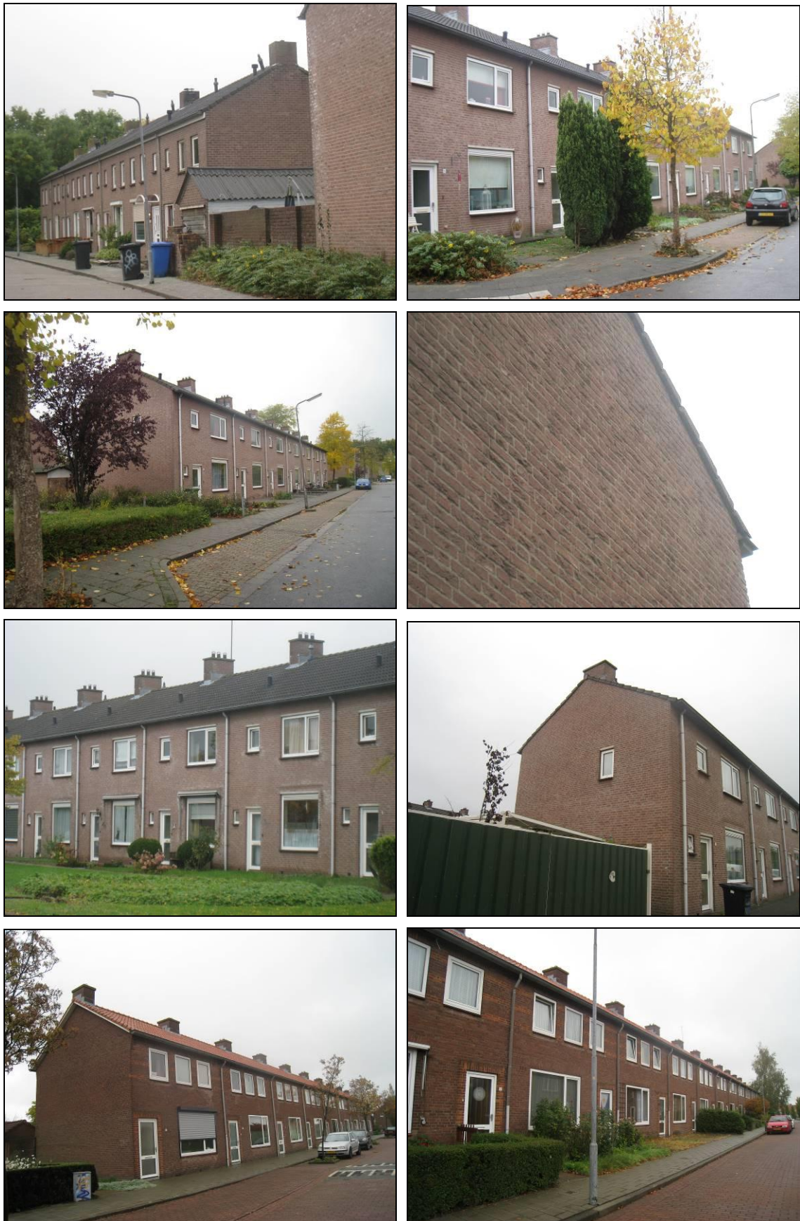
Figuur 2. Aanzicht van het de te slopen woningen te Terneuzen.
