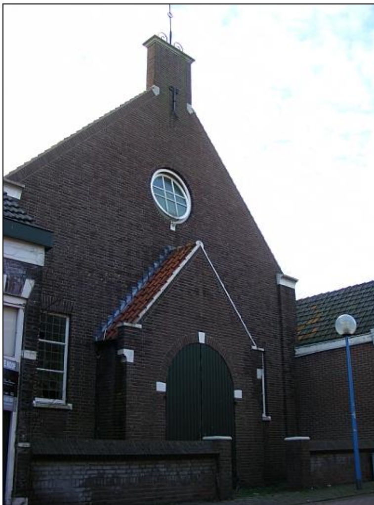
Figuur 11: De recent gesloopte gereformeerde kerk aan de Vlooswijkstraat (deelgebied 1, noordelijke deelgebied) (Bron: www.orgelsinzeeland.nl ).
