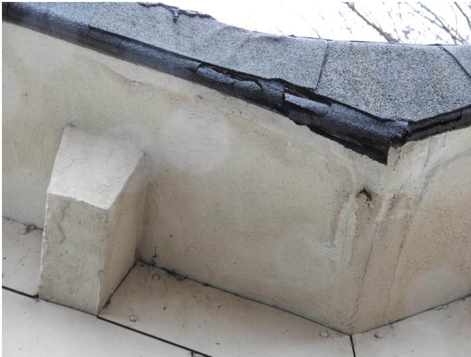
Foto 3. Kieren achter beplating.
