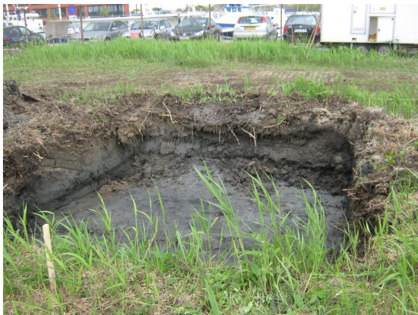
4. ontgraving niet toepasbare grond ter plaatse van locatie boring 13
