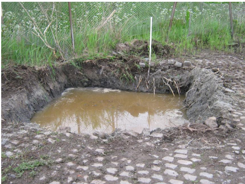
5. ontgraving niet toepasbare grond ter plaatse van locatie boring 9/141
