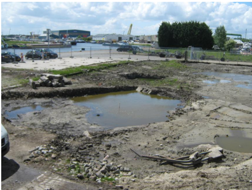
9. ontgraving resterende bovengrond binnen contour wonen ter plaatse van locatie boring 15/118
