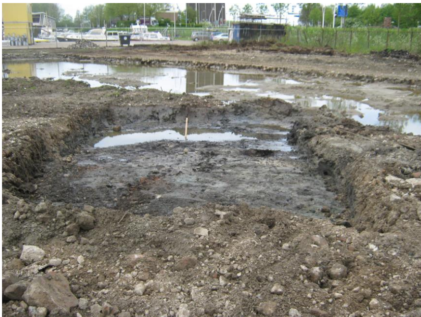
1. ontgraving niet toepasbare grond ter plaatse van locatie boring 15/118
