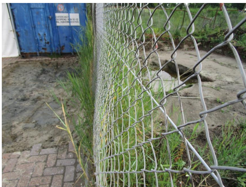
15. ontgraving aan beide zijden van het hekwerk ter plaatse van boring 24 gereed
