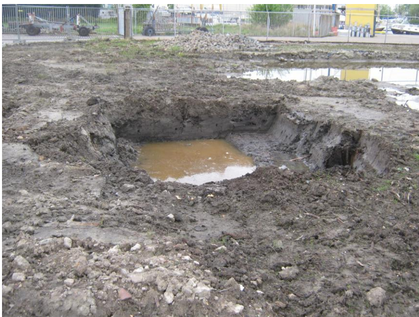
6. ontgraving niet toepasbare grond ter plaatse van locatie nabij boring 206
