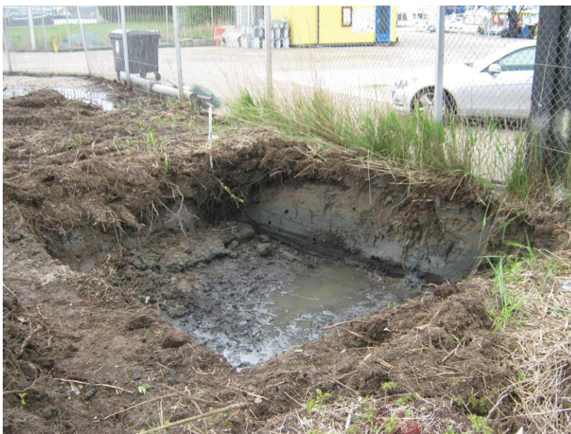
2. ontgraving niet toepasbare grond ter plaatse van locatie boring 24
