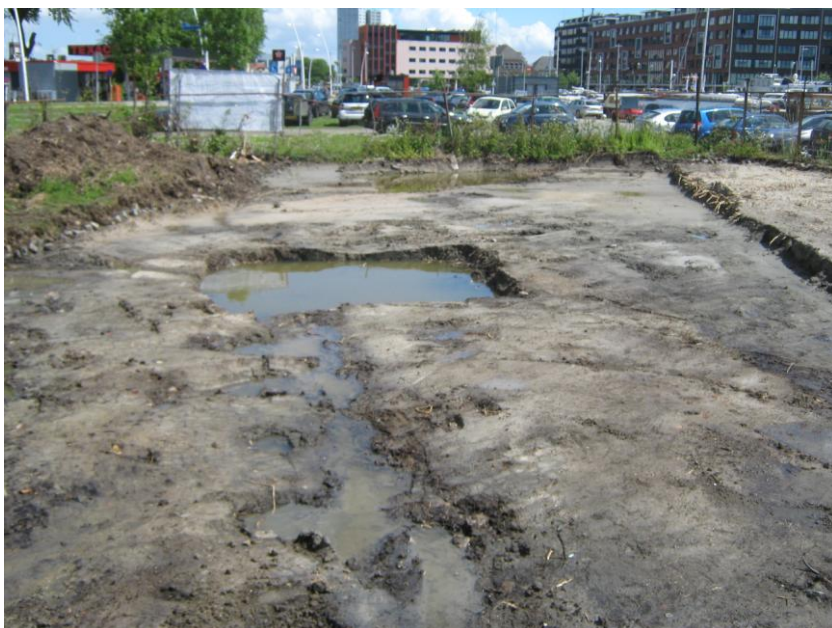
10. ontgraving resterende bovengrond binnen contour wonen ter plaatse van locatie boring 102/13
