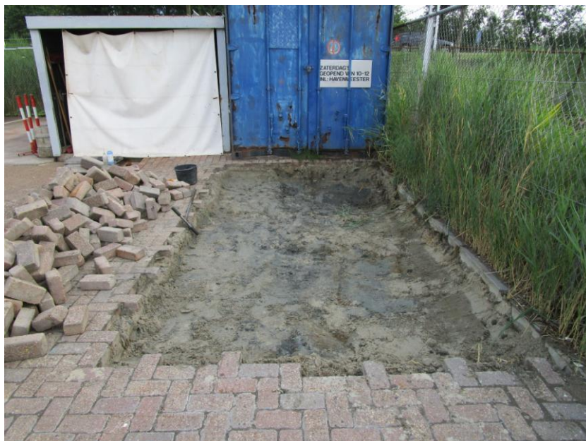
14. ontgraving ter plaatse van opslagcontainer nabij boring 24
