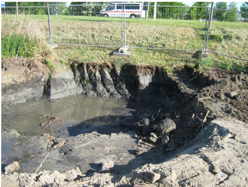
7. ontgraving resterende bovengrond binnen contour wonen ter plaatse van locatie boring 9/141
