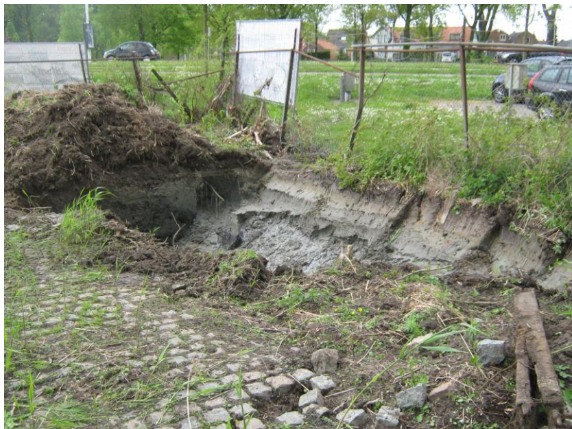
3. ontgraving niet toepasbare grond ter plaatse van locatie boring 102
