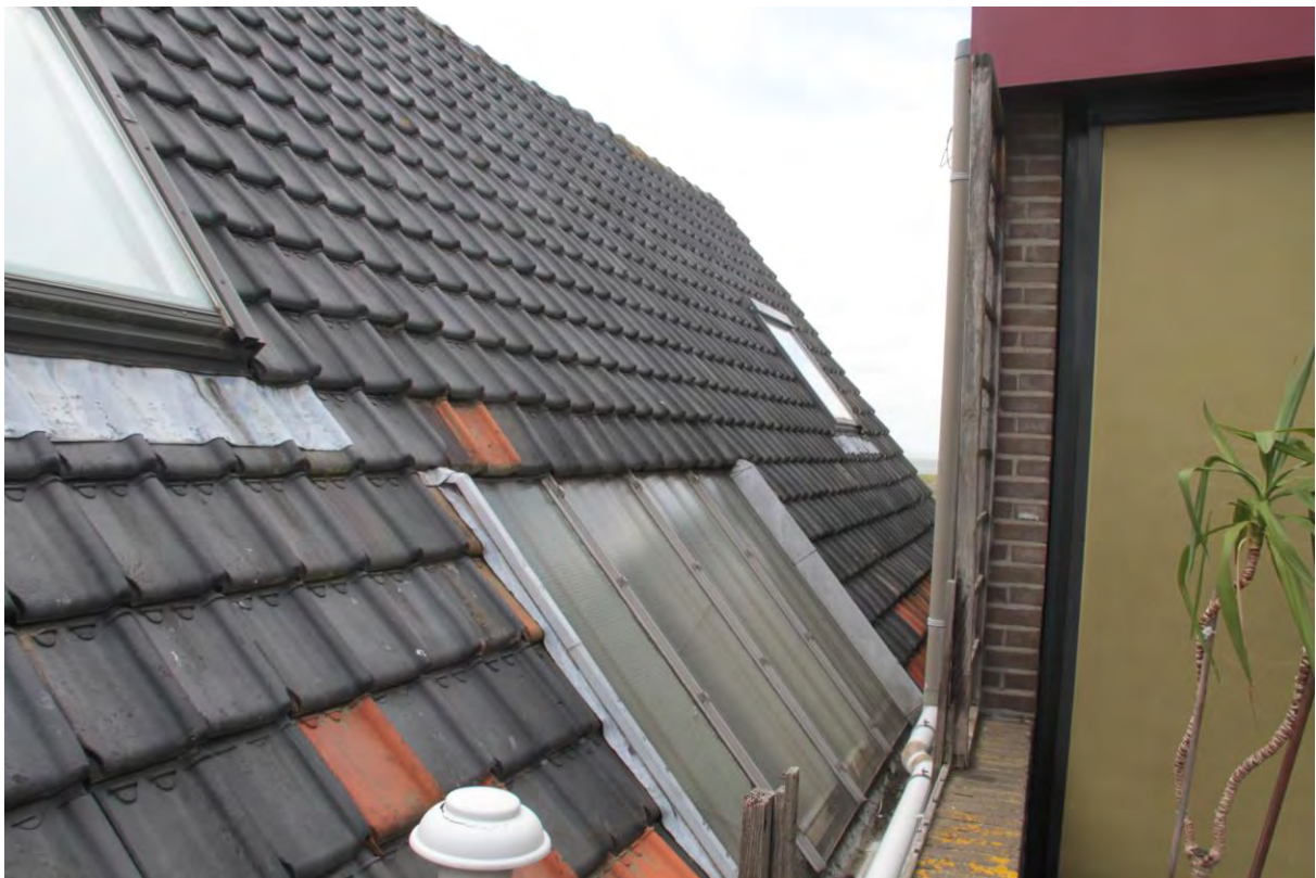
Foto 5. Dak, geen Huismus of Gierzwaluw vastgesteld.
