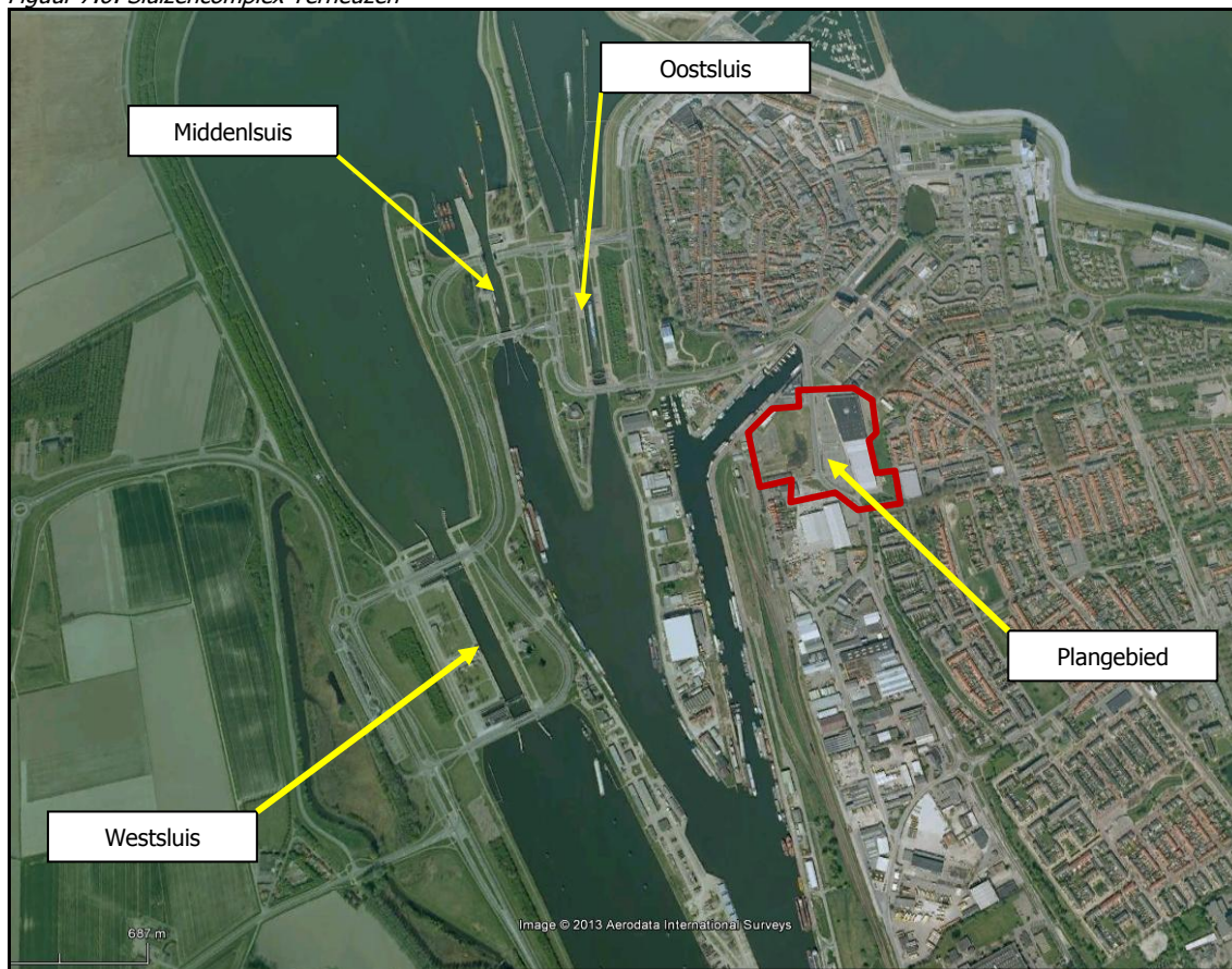
Figuur 7.6: Sluizencomplex Terneuzen
