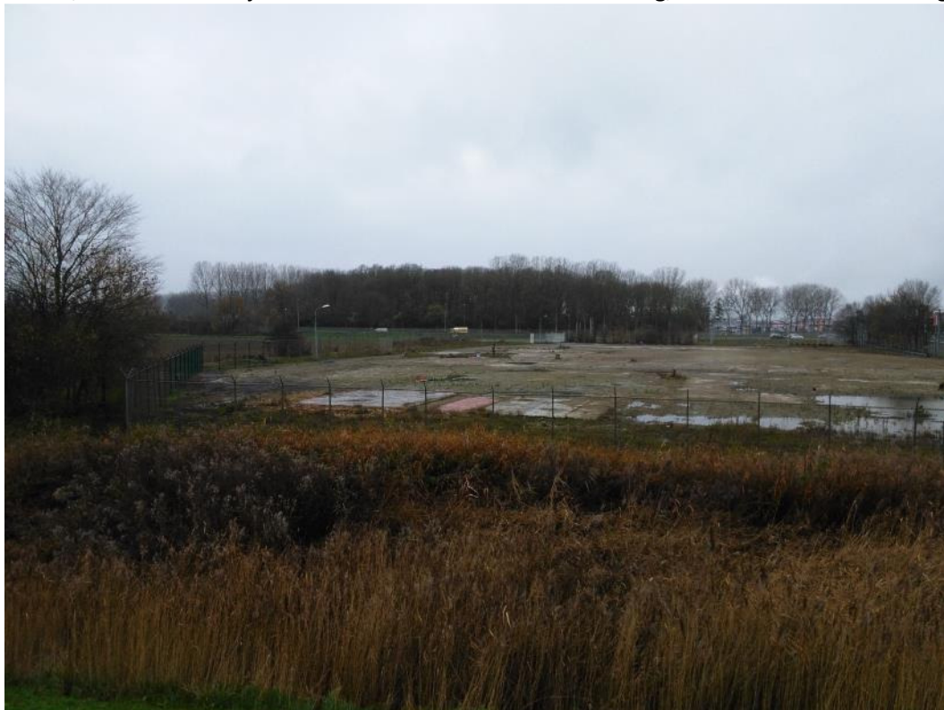
Foto 8; Overzicht bedrijfsterrein vanaf talud Willemskerkeweg/Westerscheldetunnelweg
