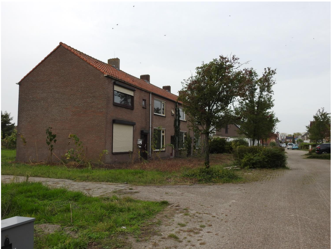
Foto 1. Te slopen woningen.
