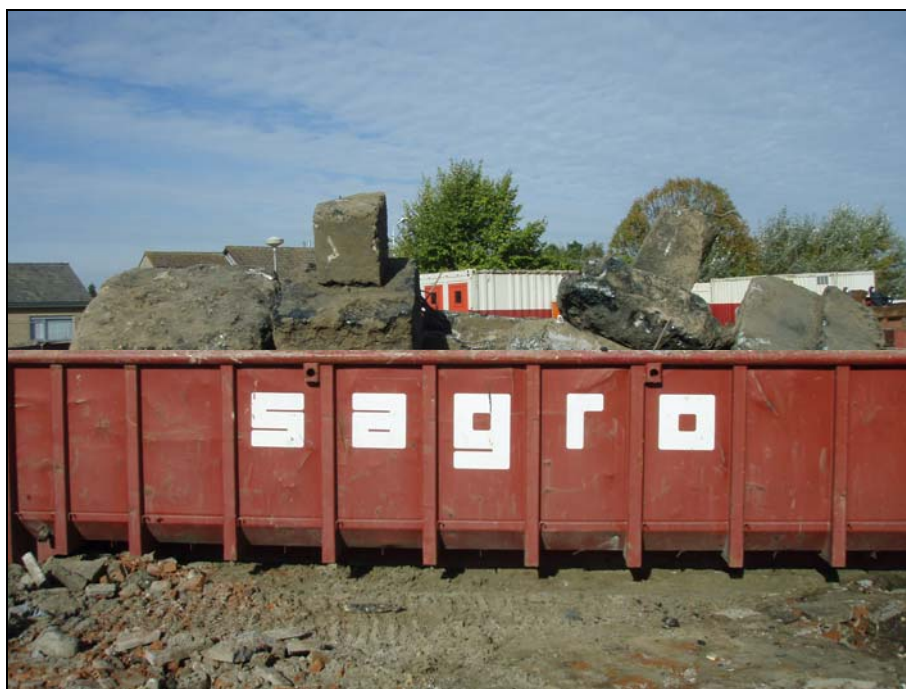
Abbeelding 28. De betonnen funderingspoeren van het voormalige schoolgebouw.
