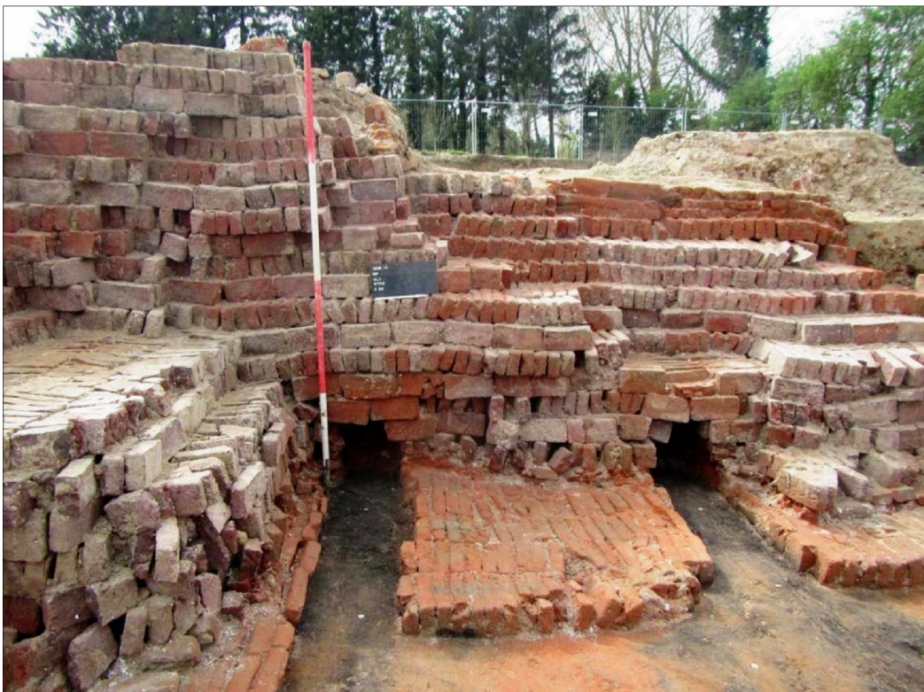
Afbeelding 10 Detailfoto van twee stookkanalen van baksteenoven 1 aangetroffen aan de Westkaai te Ieper. Bron: De Gryse en Boncquet, 2014, figuur 67.
