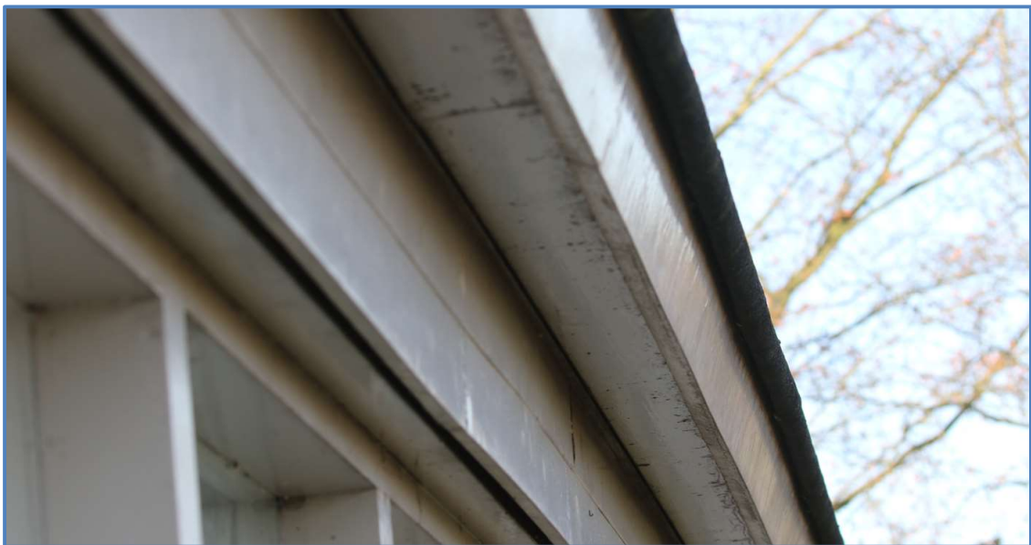
Voor vleermuizen ontoegankelijke dakrand van bijgebouw.
