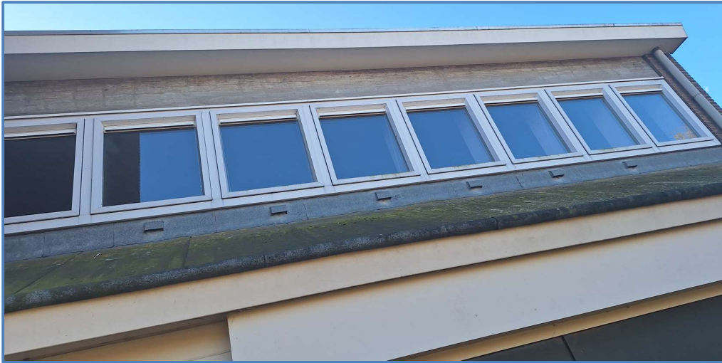
In het de af te breken kerk en bijgebouwen bevinden zich nergens potentiële verblijfplaatsen van vleermuizen, noch broedplaatsen van gierzwaluw of huismus.
