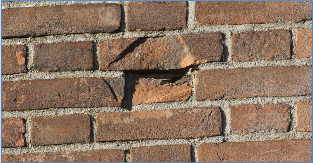
Op afstand lijkt dit een holte in de kerkmuur. Dat is het echter niet.
