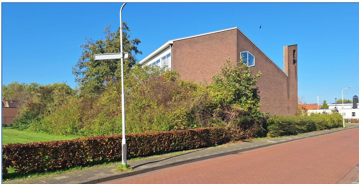
Het af te breken kerkgebouw met groenstrook gezien vanaf de Spoorstraat op 24 oktober 2024. Bij het tweede bezoek op 6 december 2024 bleek de groenstrook geheel te zijn gerooid.
