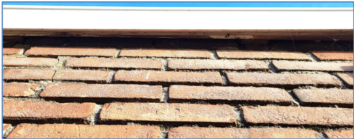
Voor vleermuizen ontoegankelijke dakrand van bijgebouw.
