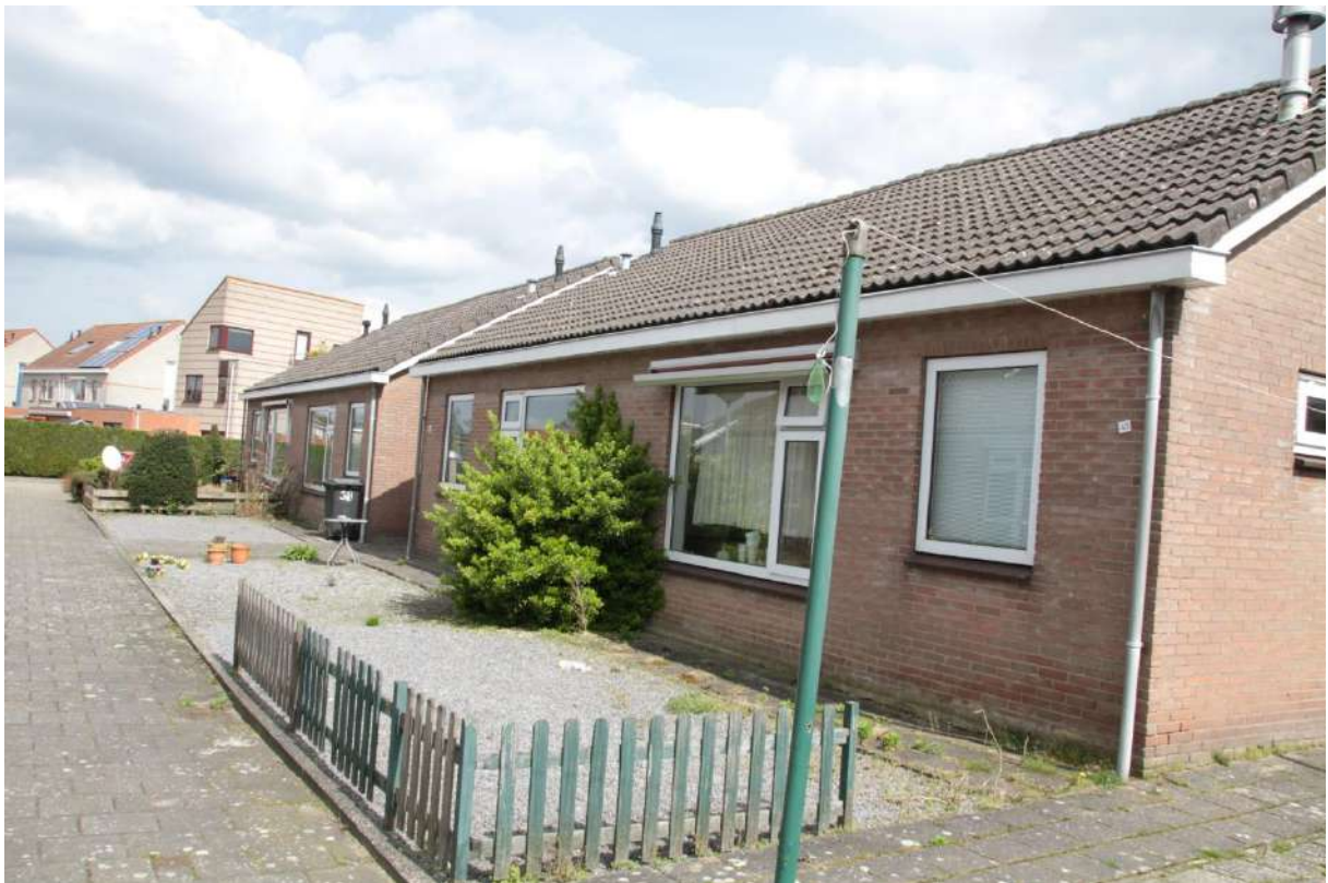
Foto 1. Te slopen woningen.
