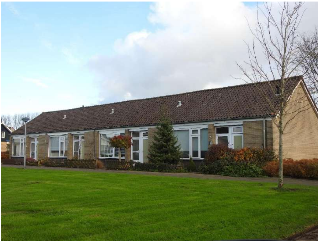
Foto 1. Te slopen woningen.
