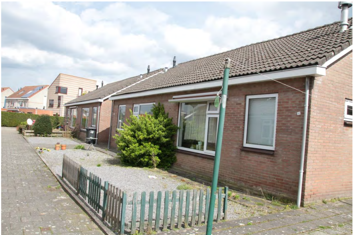
Foto 1. Te slopen woningen.
