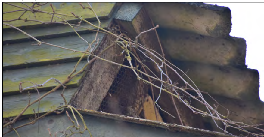
Figuur: de openingen in het dak van de schuur zijn dichtgemaakt met kippengaas. Hierdoor kunnen onder andere uilensoorten de schuur niet bereiken.
