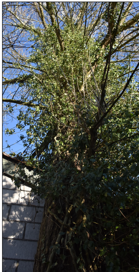
Figuur: er staat een met klimop begroeide boom tegen de schuur aan. Hier kunnen mogelijk holtes in aanwezig zijn die als verblijfplaats voor vleermuizen kunnen dienen. Ook kunnen vogels zonder jaarrond beschermd nest hier broeden.
