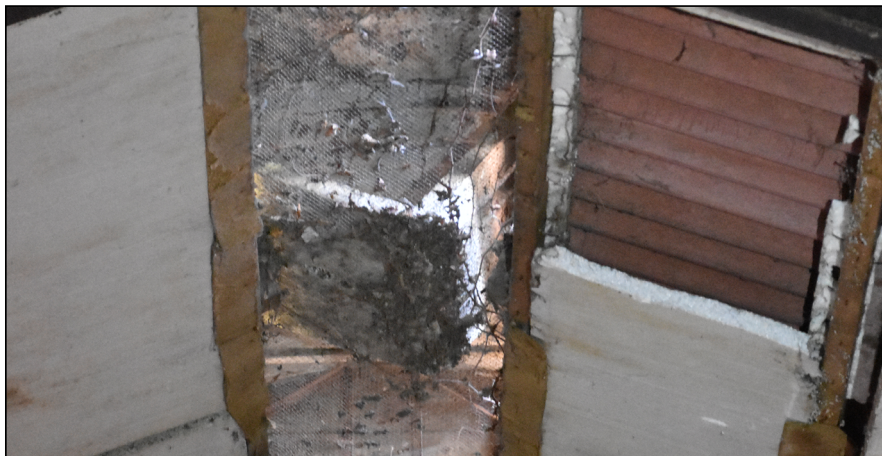
Figuur: het dak van de schuur is van binnenuit bekleed met piepschuim. Tussen de golfplaten en het piepschuim is ruimte waar mogelijk verblijfplaatsen van vleermuizen aanwezig zijn. Openingen in het dak zijn afgesloten met kippengaas. Dit maakt aanwezigheid van uilensoorten niet mogelijk.
