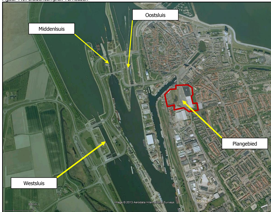
Figuur 7.6: Sluizencomplex Terneuzen
