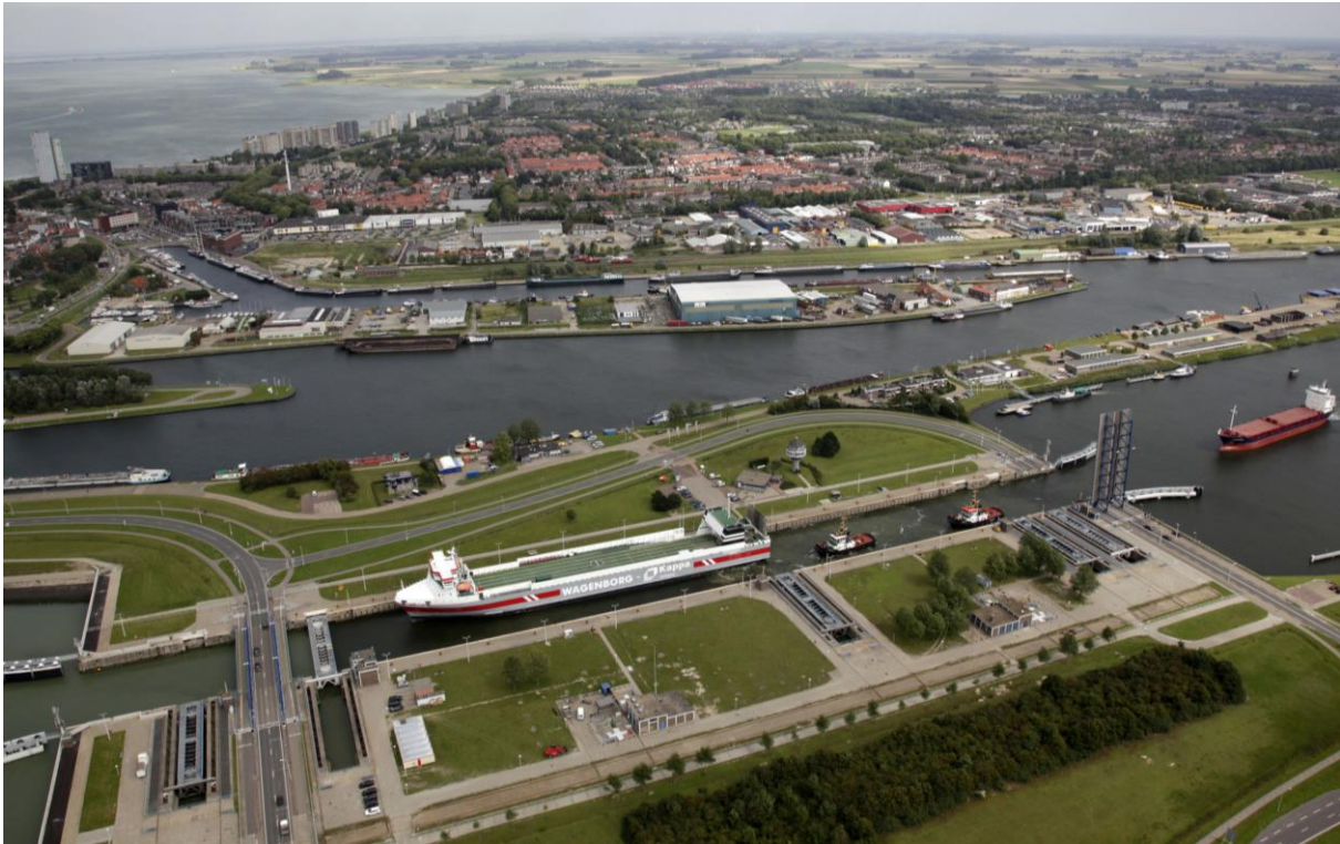
Afbeelding 2.2.: zicht op het zeesluizencomplex vanuit de lucht (bron: PZC).
