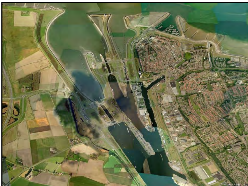
Figuur 1: luchtfoto sluizencomplex (Bing Maps 2014)
