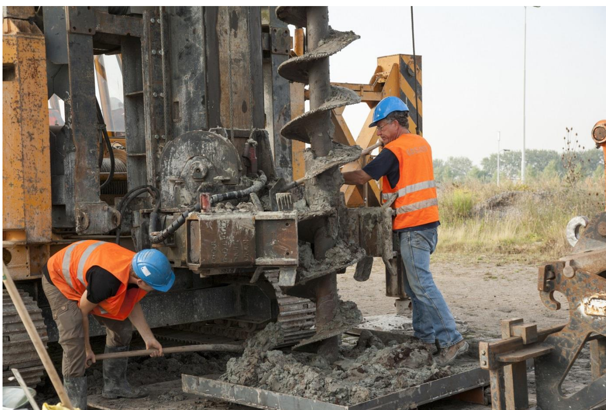
Foto 7 en 8. Het sediment dat daarna nog in de schoepen bleef hangen en het materiaal dat naast de opvangbak op de vlonder was gevallen, werd handmatig in de bak geschept. Foto: Nieuwe Sluis Terneuzen - Mark Neelemans Fotografie
