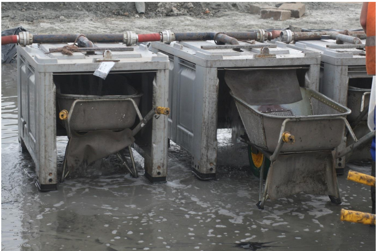
Foto 32. Het spoelen van de kruiwagen met sediment in de zeefinstallatie ('hondenhokken'). Foto 24. Foto Menno van den Berg.
