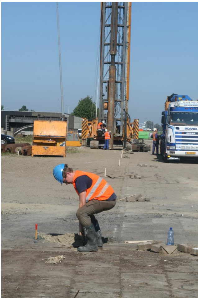
Foto 1. Avegaarbooropstelling op de locatie A17. Aan weerszijden van de foto liggen de genomen bigbag monsters uit de boorkernen te wachten voordat ze gezeefd gaan worden. Foto Menno van den Berg.
