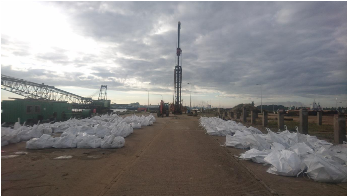
Foto 1. Avegaarbooropstelling op de locatie A17. Aan weerszijden van de foto liggen de genomen bigbag monsters uit de boorkernen te wachten voordat ze gezeefd gaan worden. Foto Menno van den Berg.
