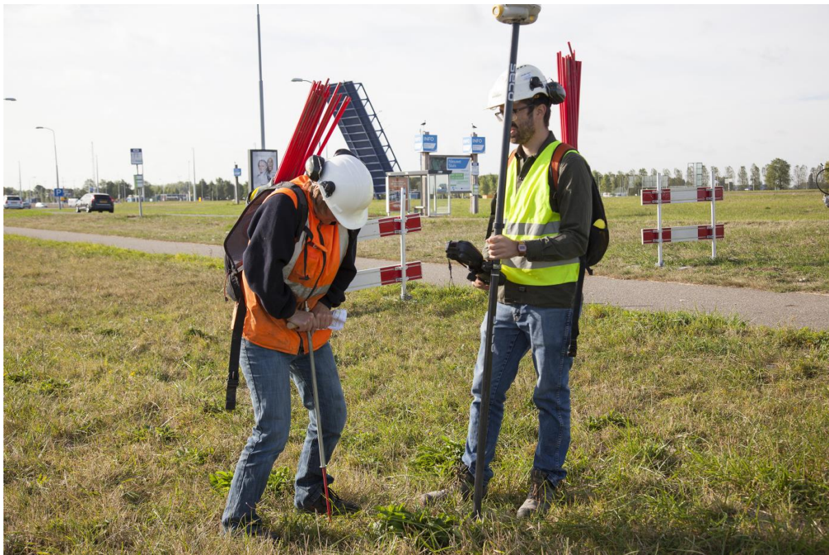
Foto 39. Uitzetten van de boorpunten op locatie A29. Foto: Nieuwe Sluis Terneuzen - Mark Neelemans Fotografie
