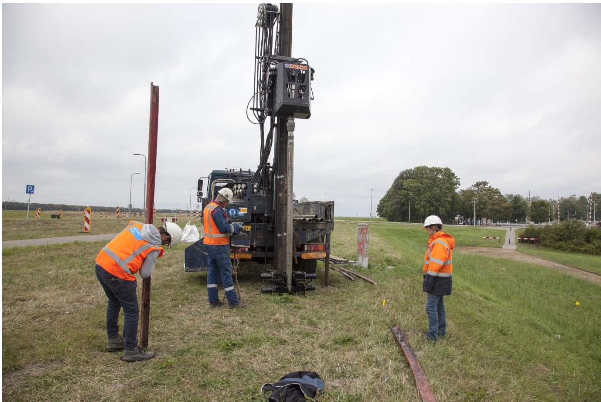
Foto 40. De uitvoering van een sonic drill boring. Foto: Nieuwe Sluis Terneuzen - Mark Neelemans Fotografie.
