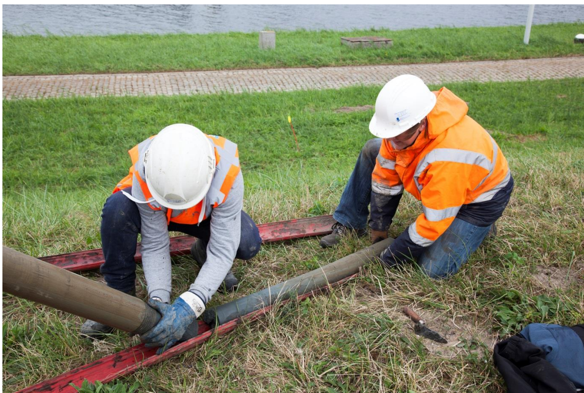
Foto 41. Het uitdrukken van het boorsediment in de opvangschuit. Foto: Nieuwe Sluis Terneuzen - Mark Neelemans Fotografie
