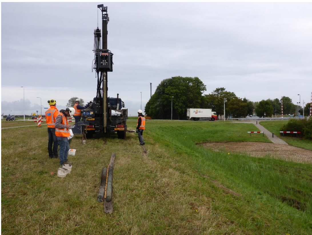
Figuur 3: boring met de Sonic Sample Drill (foto: GATE)
