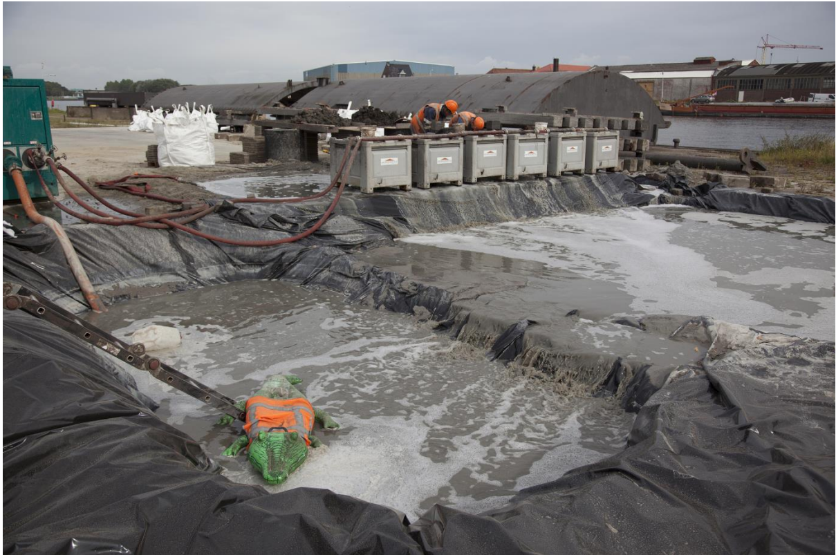
Foto 29. De zeefopstelling bestaande uit 6 'hondenhokken' waarin de zeefkruiwagens met sediment werden gespoeld. Foto: Nieuwe Sluis Terneuzen - Mark Neelemans Fotografie.
