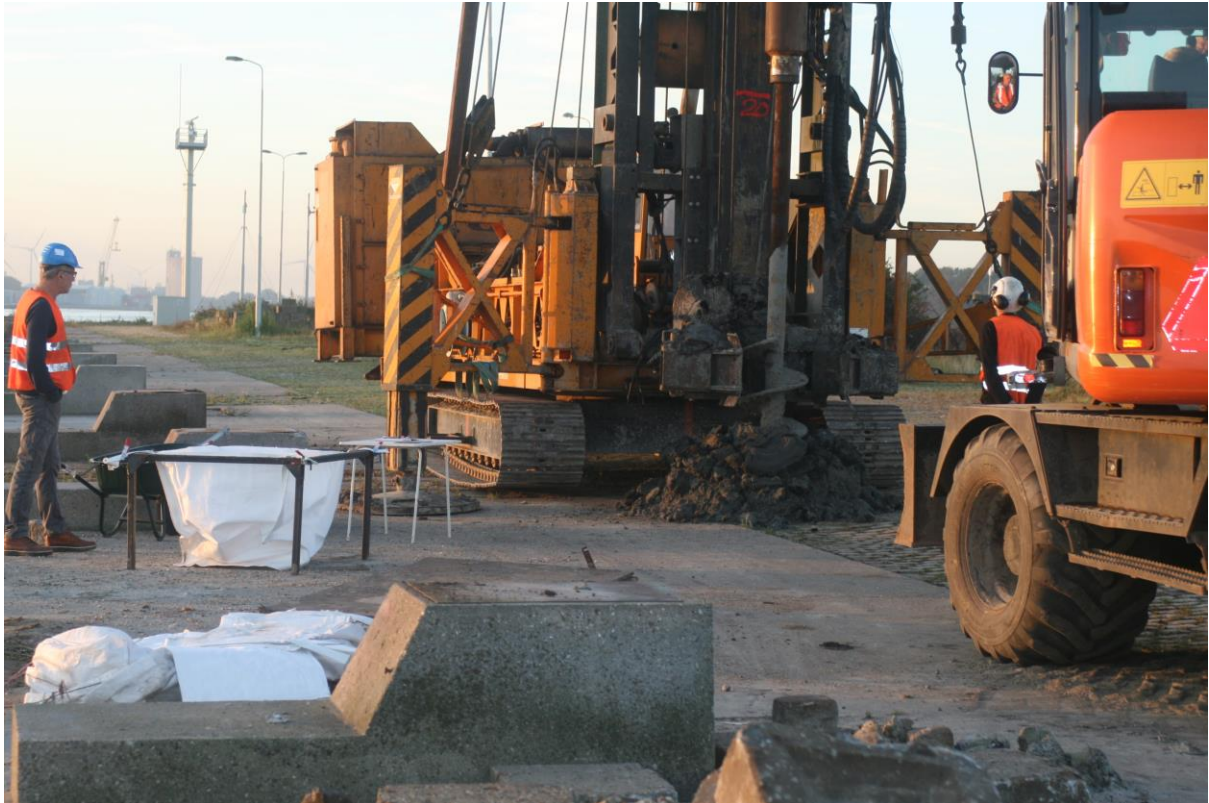
Foto 3. Start van de boring A17-49. De avegaarboorspiraal zit op diepte, ca. 19 m –NAP. Bij het op diepte brengen van de boor wordt door de opwaartse druk een deel van de bovengrond omhoog gedrukt en komt naast het boorgat te liggen.
