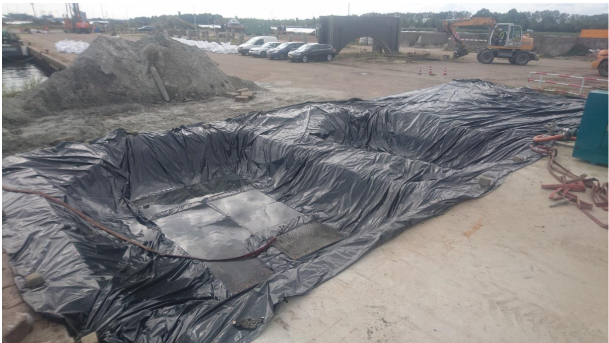
Foto 27. De aanleg van de zeefput op de locatie A17. Foto Menno van den Berg.
