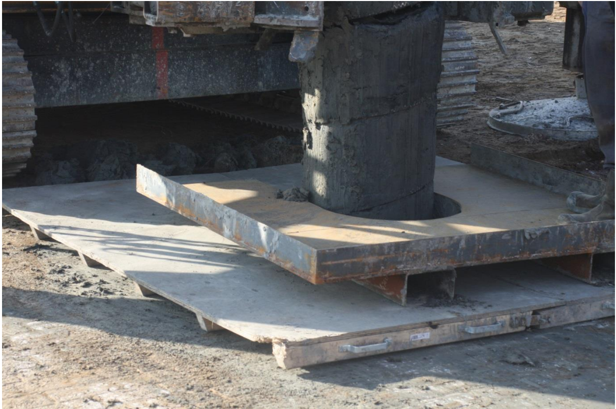
Foto 5. De houtenbasisvlonder en de sedimentopvangbak voor de bemonstering van de Pleistocene afzettingen.
