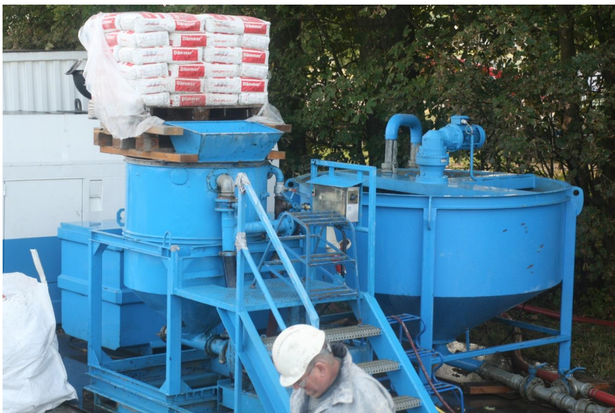
Foto 25. De menginstallatie waarmee de dämmert in poedervorm in de (zakken) werd opgelost voordat het in het boogat werd gespoten. Het afdichten met dämmert was noodzakelijk in verband met de dijkveiligheid.
