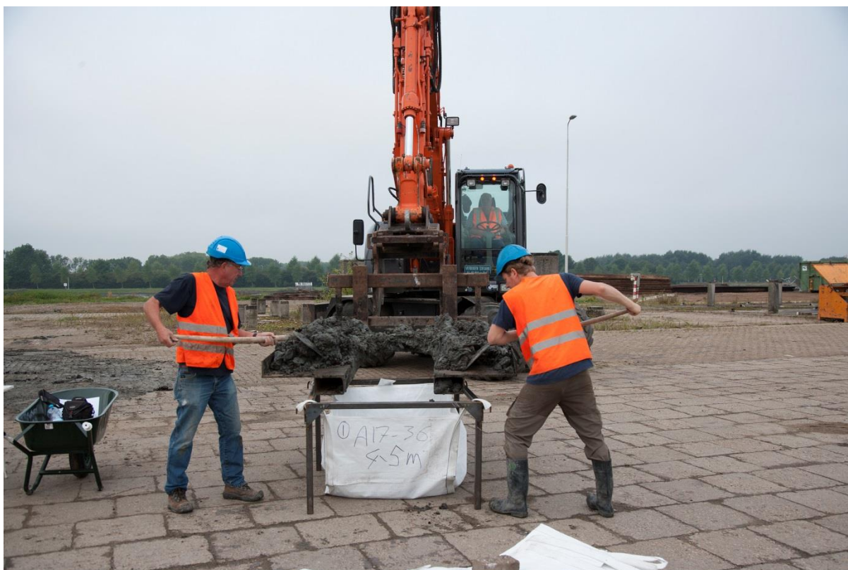
Foto 9. Na de bemonstering van het sediment in de opvangbak werd handmatig het sediment in de bigbags geschoven. Foto: Nieuwe Sluis Terneuzen - Mark Neelemans Fotografie.
