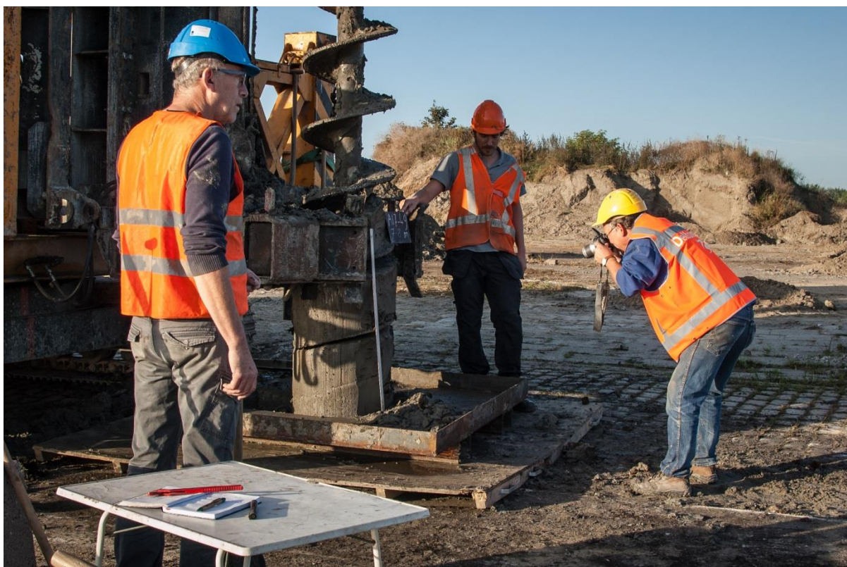
Foto 10. Voor de monstername uit de avegaarkern werd elke bemonsterde meter eerst vastgelegd doormiddel van een foto. Foto: Nieuwe Sluis Terneuzen - Mark Neelemans Fotografie.
