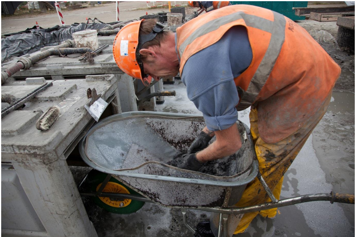
Foto 33. Het monsterresidu in de kruitwagen na het spoelen van het monster Foto: Nieuwe Sluis Terneuzen - Mark Neelemans Fotografie
