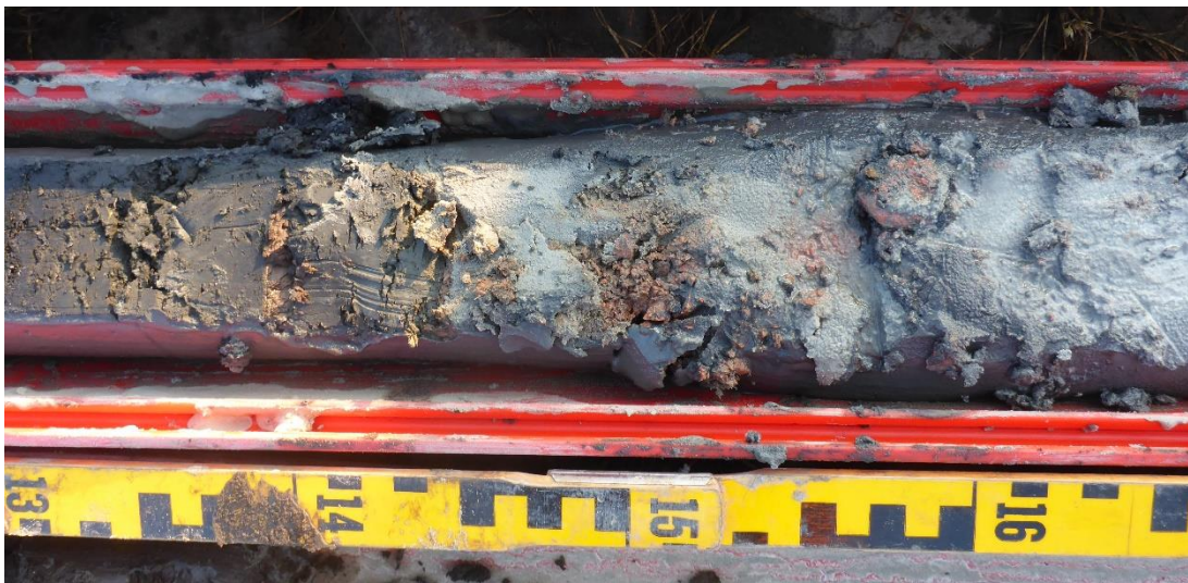
Figuur 14: puinlaag onderaan het dijklichaam.
