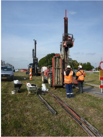
Fig 7: Boren met twee machines tegelijk.
