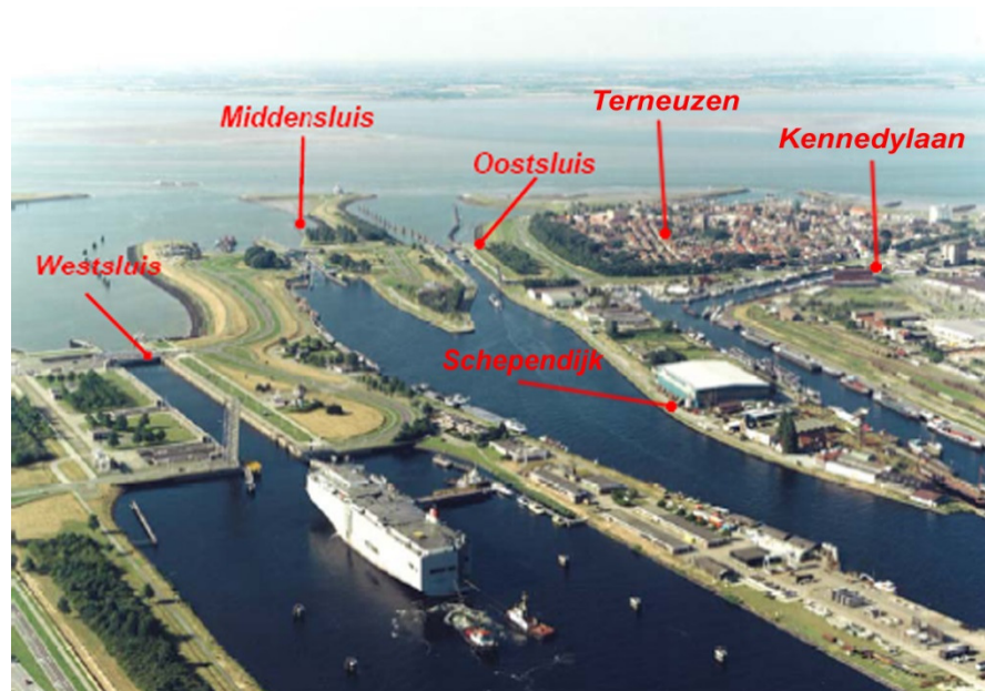
Figuur 2-2 Overzicht Sluizencomplex Terneuzen
