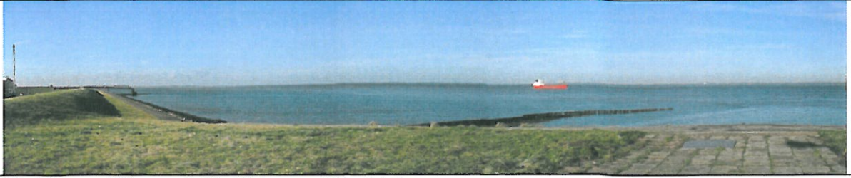
Uitzicht vanaf Westerscheldedijk in westelijke richting
