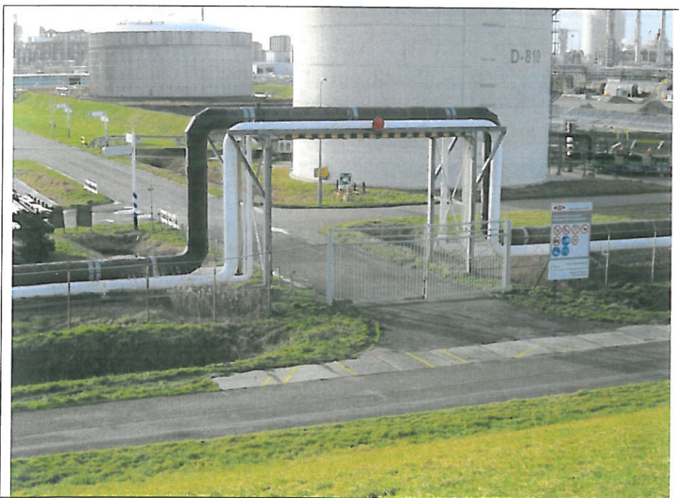
Huidige Poort 2 gezien vanaf de Westerschelde dijk
