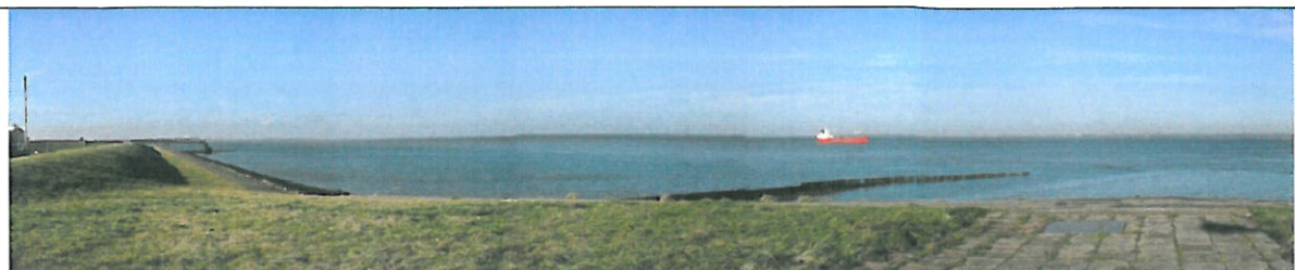
Uitzicht vanaf Westerscheldedijk in westelijke richting
