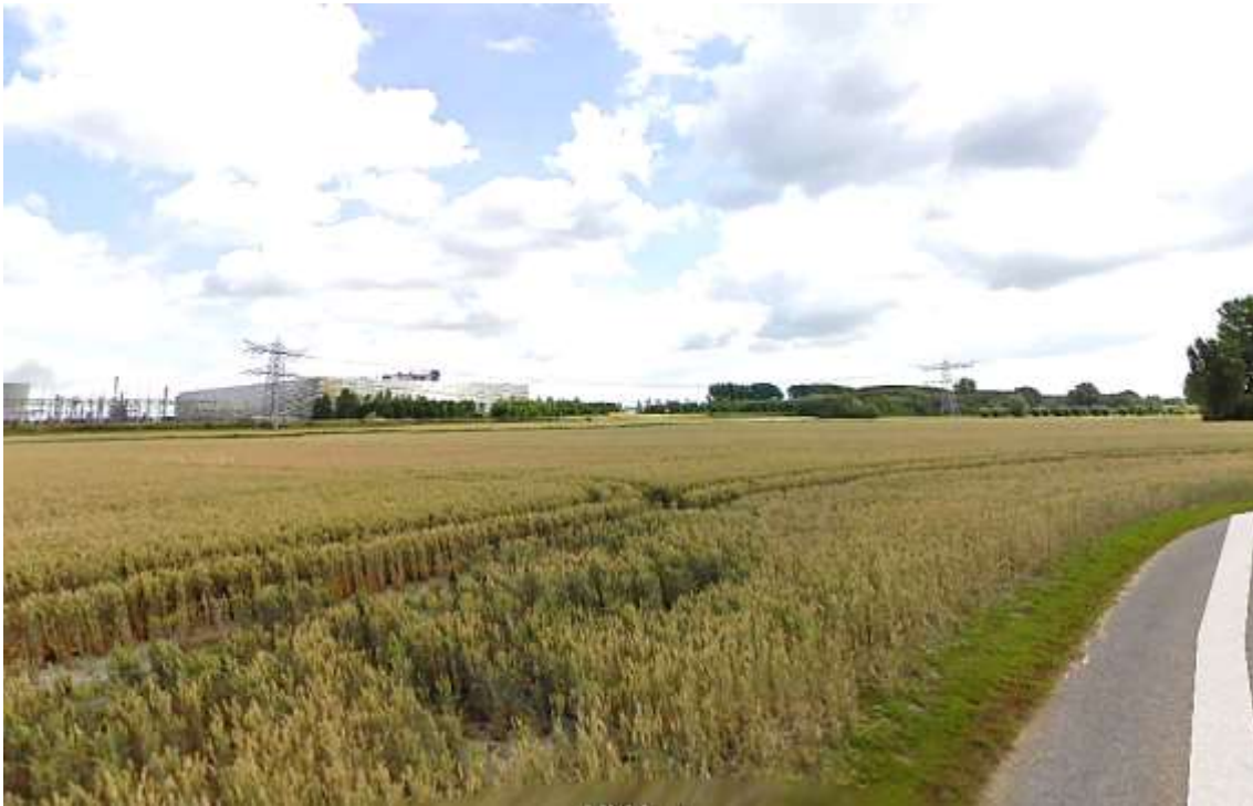
Figuur 12.16 Uitzicht vanaf de Lovenpolderstraat richting Dow/MVP, locatie G (Bron: streetview, Google Earth)
