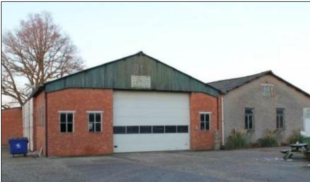
afbeelding 2.1, inmiddels gesloopte bedrijfsbebouwing aan Het Zand 12
