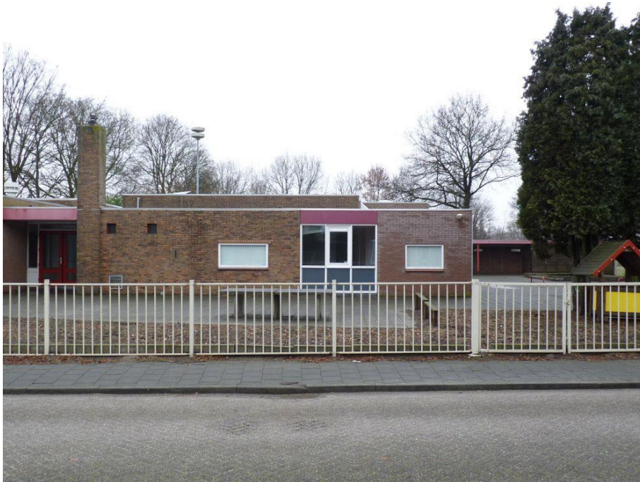
Figuur 6 Het voormalig schoolgebouw Boekweitstraat 10
