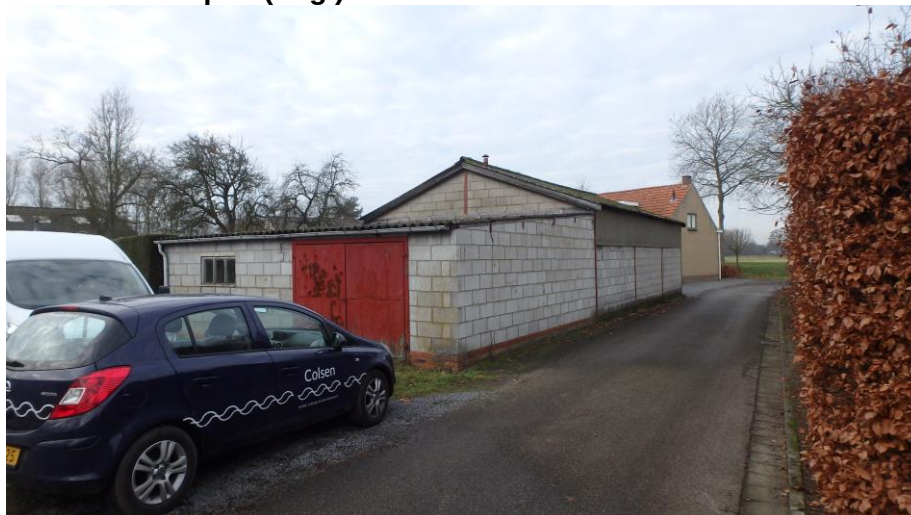
foto 1: ligging oude loods (noordwestelijke richting)
