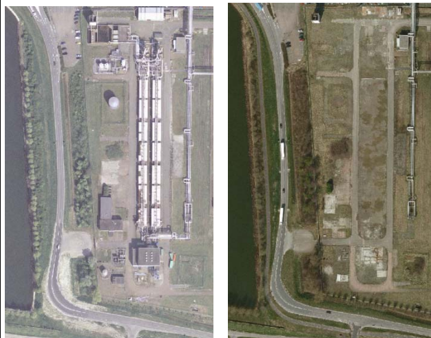
Figuur 8 Bedrijfslocatie tegenover bluswaterberging: links situatie 2007, rechts situatie sinds 2009
