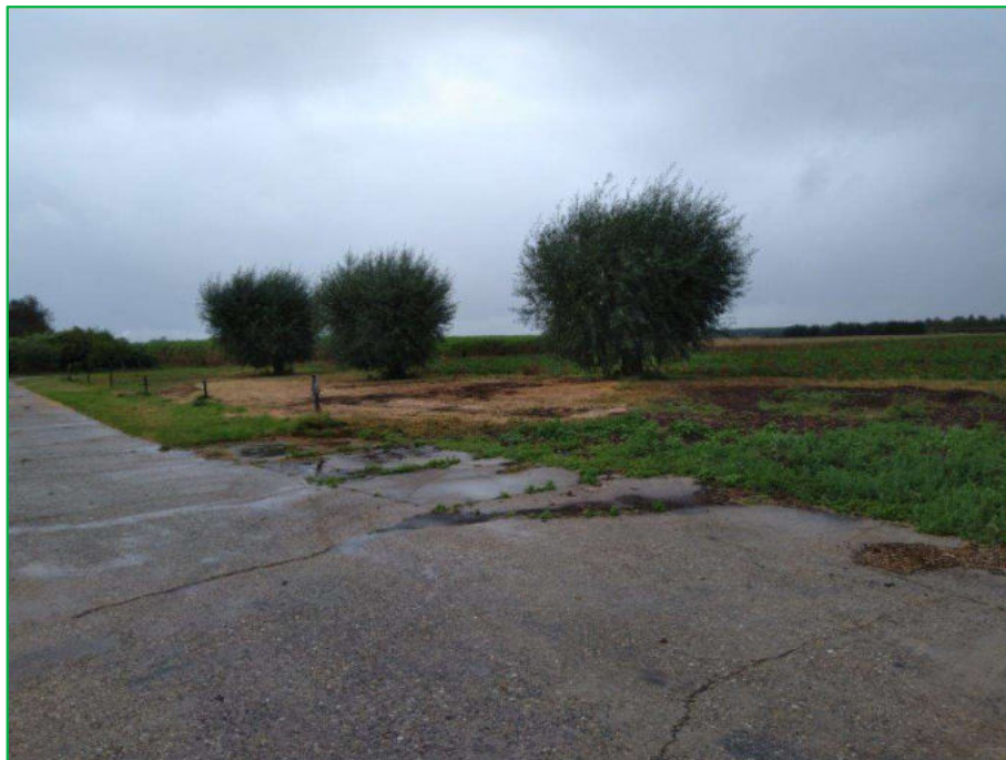
Foto 1 locatie voormalige schuur/overkapping
