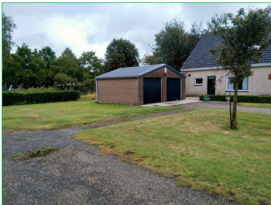
Foto 4 voor garagedeuren is sprake van een grondverontreiniging met PAK
