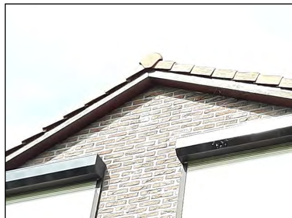
Figuur 22. Ruimtes onder de kant- en nokpannen van de bebouwing van de Gravin Mariaweg 1.
