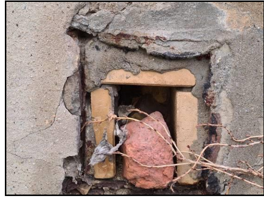
Afbeelding 8: Toegang tot ruimte in/onder woning
