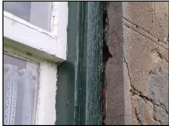
Afbeelding 5: Ruimte langs kozijnen
