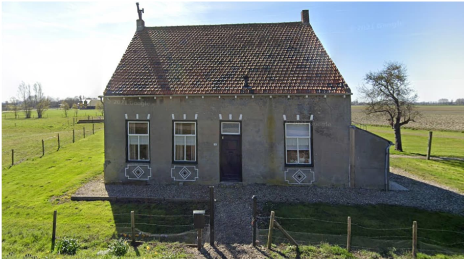
Figuur7 Te verwijderen pand aan de Lovenweg nr. 4.; (foto Google Earth)
