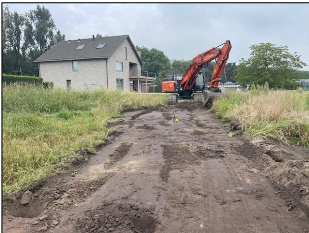
Foto 3: Eindsituatie putbodem AB02 na uitvoering sanering
