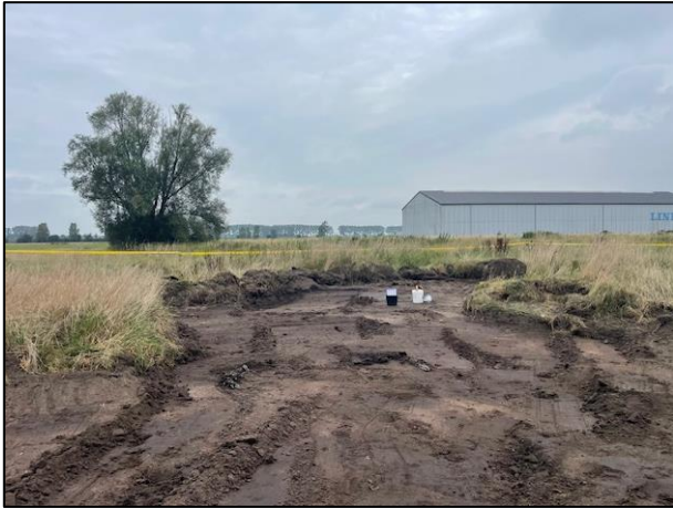
Foto 1: Eindsituatie putbodem AB01 na uitvoering sanering
