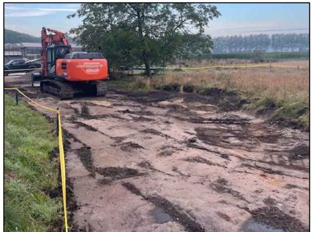
Foto 4: Eindsituatie putbodem AB03 na uitvoering sanering
