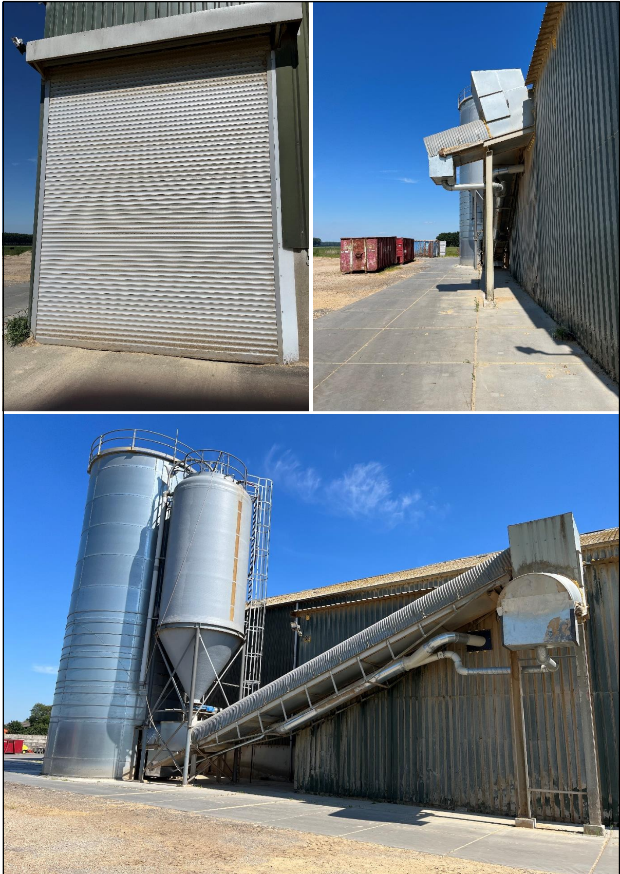
Figuur 4.2: foto's van reparatie roldeur en afpurren invoer en afzuiging [Derks Advies]
