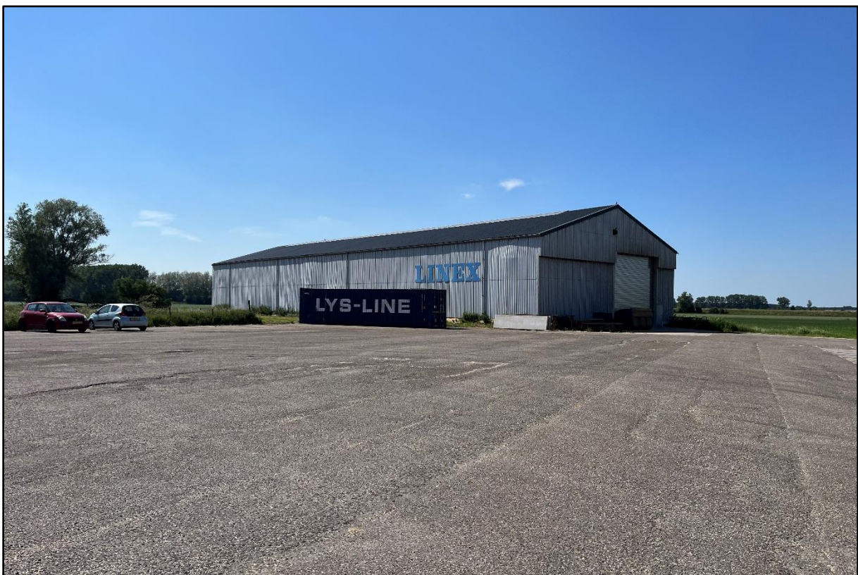
Figuur 4.4: foto gesloten deur bij opslaghal, waar de nieuwe opslag naast komt [Derks Advies]
