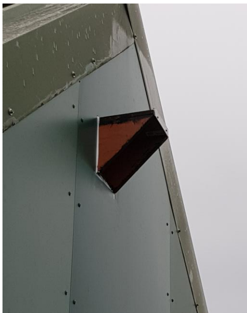
Nieuwe uitvoering van afgeschuinde in/uitlooppijp.
