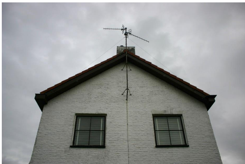
Figuur 4.4.1. De woning aan de Zandstraat 102 bevat geen open stootvoegen.
